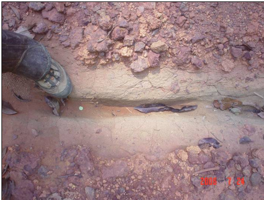
Foto 5 - Detalhe de sulcos erosivos abertos por ocasião do escoamento superficial pluvial (coordenadas 0551066; 9804340).
