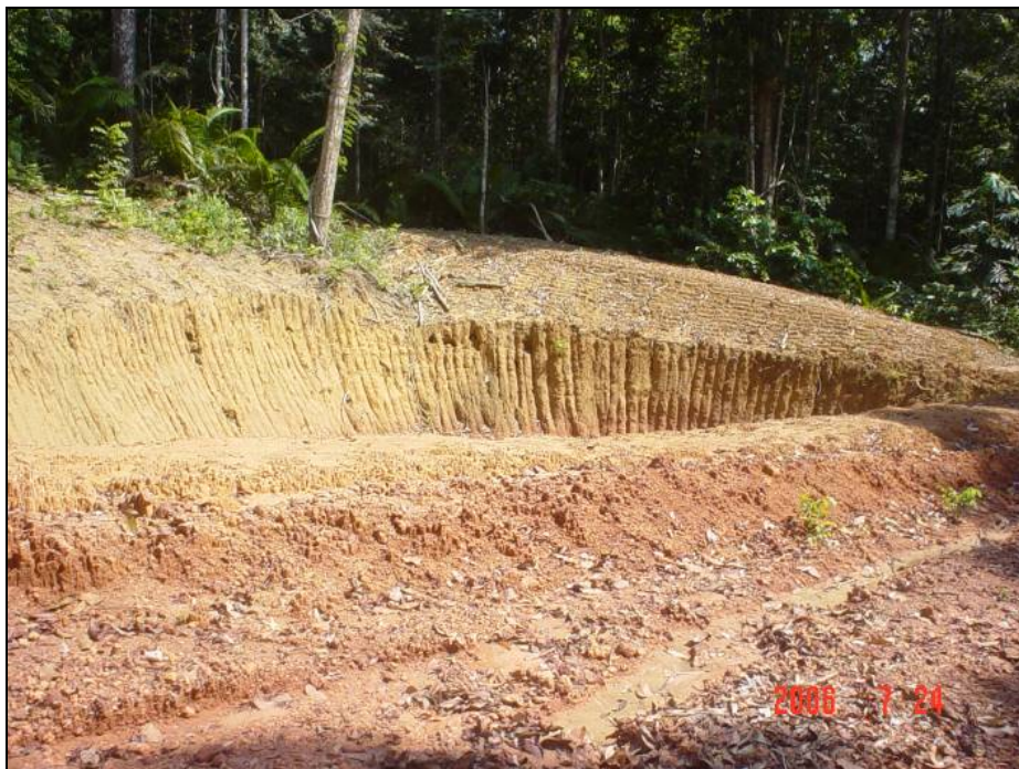
Foto 6 - Bacia de contenção de água pluvial associada a sistema de drenagem (coordenadas UTM 0551066; 9804340).
