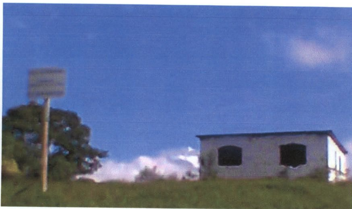
Figura 4. Casa com o processo de construção suspenso devido à notícia de passagem do mineroduto da Ferrous. Comunidade dos Almeidas.
