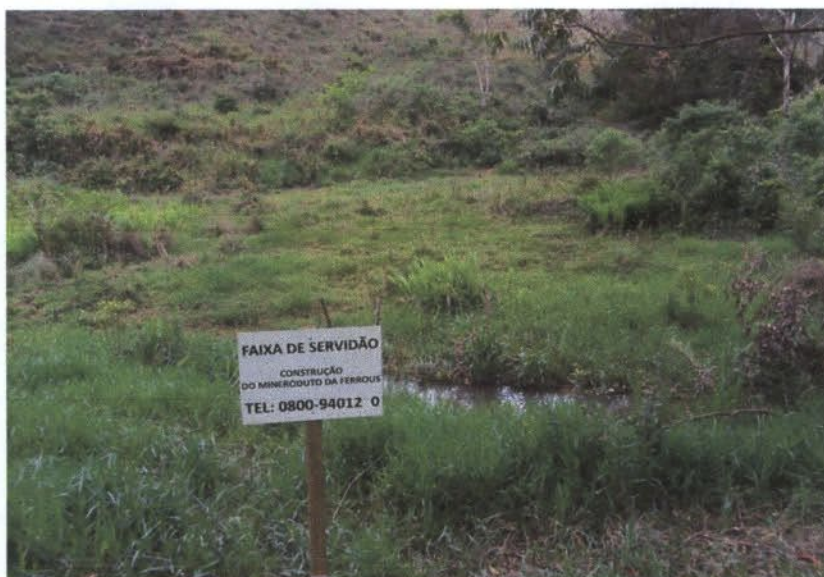
Figura 5: Placa evidenciando passagem do mineroduto em cima do córrego
