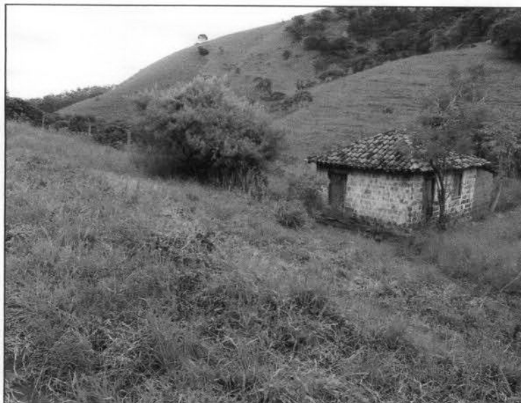
Figura 1 – Residência rural de propriedade de Arcanjo Sabóia, situada cerca de 12 metros do limite leste do imóvel Valão Danta.
