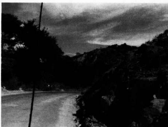
Foto 22 – Área susceptível a erosão
