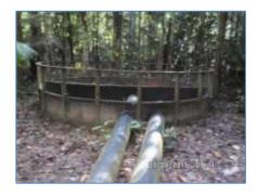
Situação em Dezembro/2015 MB 01 (E 0554595/ N 9817822) - Coordenada do ponto do filtro gabião Tubulação com filtro na captação de água e dissipador de energia na ponta inferior.
