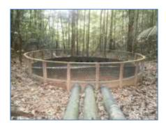
Situação em Dezembro/2015 MB 12(E 0551999/ N 9818636) - Coordenada do ponto do filtro gabião Tubulação com filtro na captação de água e dissipador de energia na ponta inferior.
