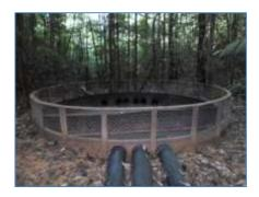
Situação em Dezembro/2015 MB 11(E 0552299/ N 9818587) - Coordenada do ponto do filtro gabião Tubulação com filtro na captação de água e dissipador de energia na ponta inferior.
