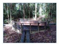
Situação em Dezembro/2015 MB 04(E 0555563/ N 9817825) - Coordenada do ponto do filtro gabião Tubulação com filtro na captação de água e dissipador de energia na ponta inferior.
