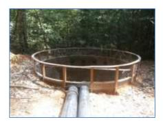
Situação em Junho/2015 MB 13(E 0554601/ N 9818602) - Coordenada do ponto do filtro gabião Tubulação com filtro na captação de água e dissipador de energia na ponta inferior.
