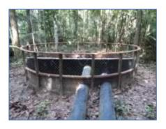
Situação em Junho/2015 MB 02 (E 0554849/ N 9817938) - Coordenada do ponto do filtro gabião Tubulação com filtro na captação de água e dissipador de energia na ponta inferior.
