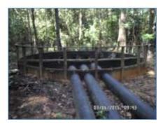
Situação em Dezembro/2015 MB 06(E 0556648/ N 9817537) - Coordenada do ponto do filtro gabião Tubulação com filtro na captação de água e dissipador de energia na ponta inferior.
