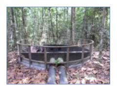
Situação em Junho/2015 MB 03(E 0555149/ N 9817939) - Coordenada do ponto do filtro gabião Tubulação com filtro na captação de água e dissipador de energia na ponta inferior.
