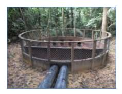
Situação em Dezembro/2015 MB 10(E 0552808/ N 9818080) - Coordenada do ponto do filtro gabião Tubulação com filtro na captação de água e dissipador de energia na ponta inferior.
