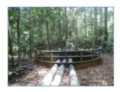
Situação em Junho/2015 MB 09(E 0553799/ N 9817565) - Coordenada do ponto do filtro gabião Tubulação com filtro na captação de água e dissipador de energia na ponta inferior.
