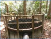
Situação em Junho/2015 MB 06(E 0556648/ N 9817537) - Coordenada do ponto do filtro gabião Tubulação com filtro na captação de água e dissipador de energia na ponta inferior.
