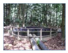
Situação em Dezembro/2015 MB 03(E 0555149/ N 9817939) - Coordenada do ponto do filtro gabião Tubulação com filtro na captação de água e dissipador de energia na ponta inferior.
