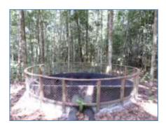
Situação em Dezembro/2015 MB 02 (E 0554849/ N 9817938) - Coordenada do ponto do filtro gabião Tubulação com filtro na captação de água e dissipador de energia na ponta inferior.
