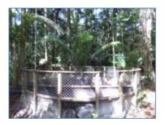
Situação em Dezembro/2015 MB 05(E 0555825/ N 9817657) - Coordenada do ponto do filtro gabião Tubulação com filtro na captação de água e dois dissipadores de energia na ponta inferior.
