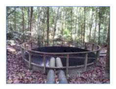
Situação em Junho/2015 MB 04(E 0555563/ N 9817825) - Coordenada do ponto do filtro gabião Tubulação com filtro na captação de água e dissipador de energia na ponta inferior.
