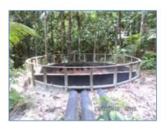
Situação em Junho/2015 MB 10(E 0552808/ N 9818080) - Coordenada do ponto do filtro gabião Tubulação com filtro na captação de água e dissipador de energia na ponta inferior.
