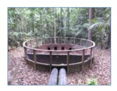
Situação em Junho/2015 MB 11(E 0552299/ N 9818587) - Coordenada do ponto do filtro gabião Tubulação com filtro na captação de água e dissipador de energia na ponta inferior.
