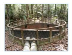
Situação em Junho/2015 MB 05(E 0555825/ N 9817657) - Coordenada do ponto do filtro gabião Tubulação com filtro na captação de água e dois dissipadores de energia na ponta inferior.
