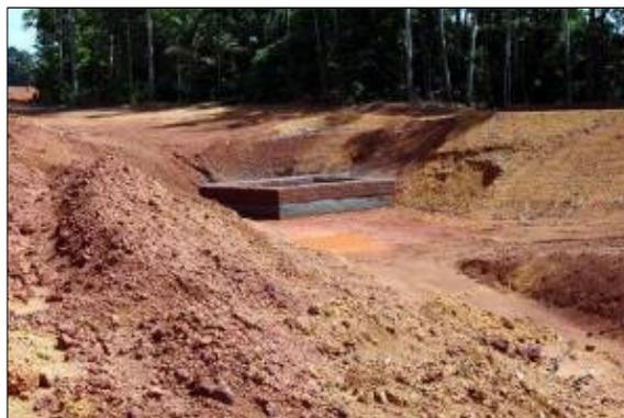
As caixas de gabião, construídas com telas metálicas, são preenchidas com minério granulado lavado, em duas ou mais camadas com forma de paralelepípedo. Sobre a camada superior é colocada uma tela tipo alambrado, para evitar a passagem de pedaços de madeira e outros materiais vegetais arrastadas pelas águas, para a tubulação de saída (Foto 3.03).
