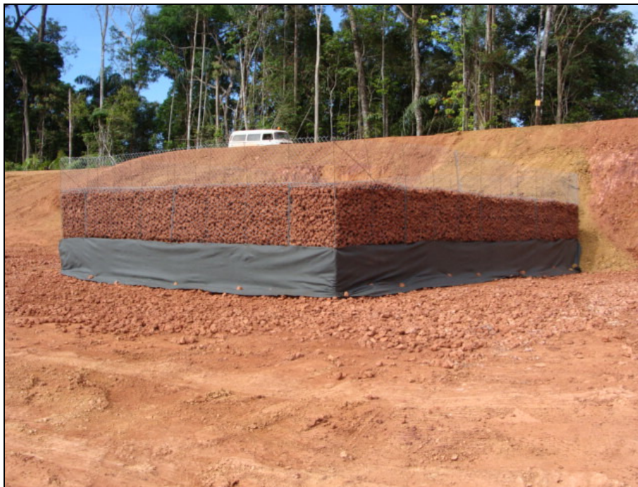
Figura 13 – Filtro de gabião instalado na borda do platô.
