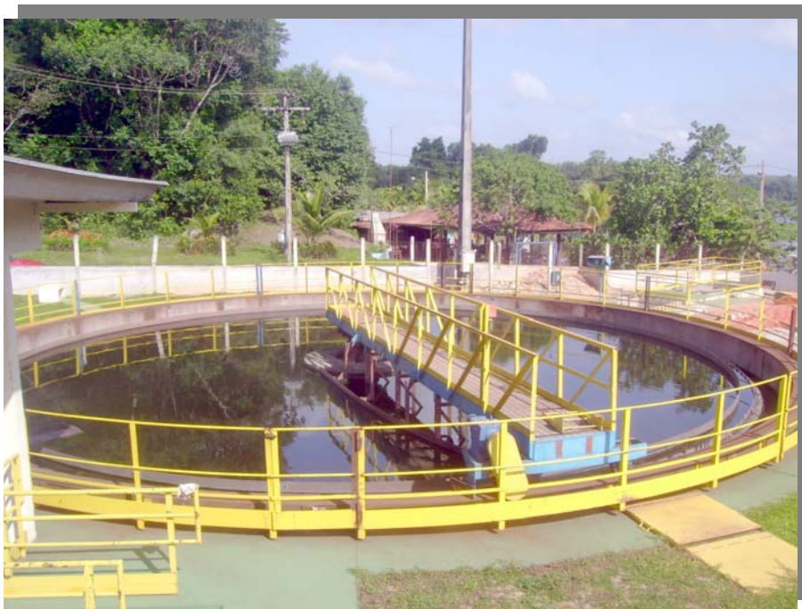
Foto 14: Tanque de Tratamento de Efluentes
