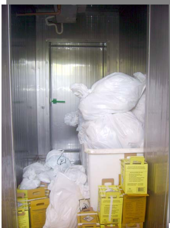
Foto 11: Câmara de Armazenamento de Resíduo Hospitalar
