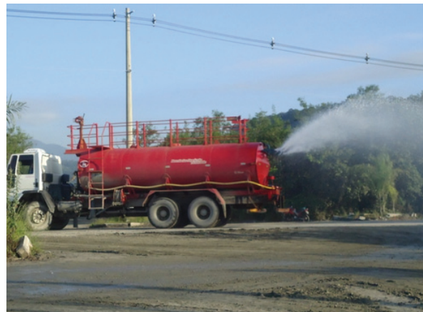
14 Aspersão de vias
