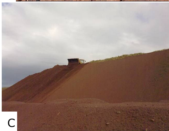
Figura 8.2.1.10-4: Sequências das atividades de reconformação topográfica. (A) Reconformação com finos. (B) Estoque de solo fértil. (C) Espalhamento do solo para posterior plantio
