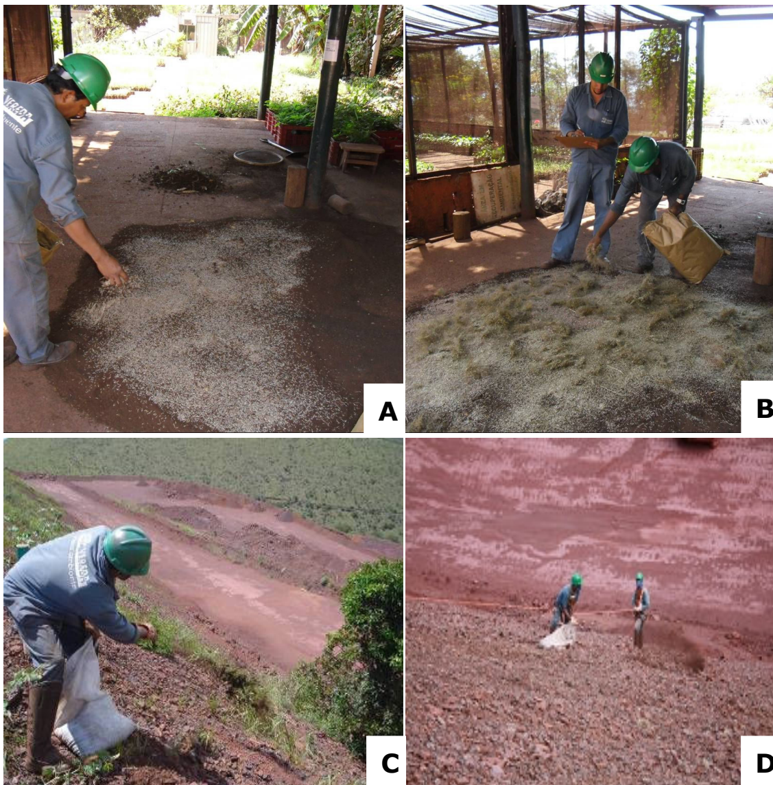
Figura 8.2.1.10-7: (A) e (B) preparação do coquetel de sementes, (C) e (D) Semeadura a lanço.
