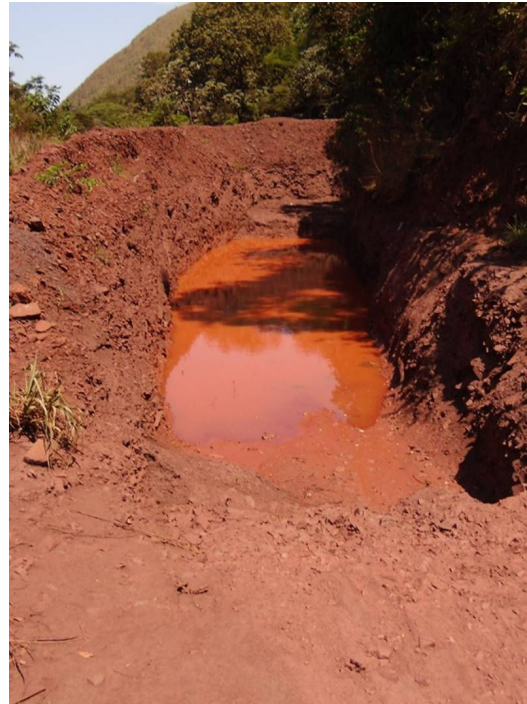
Figura 8.2.1.10-3: Sistemas de drenagem para locais de grande fluxo de água.
