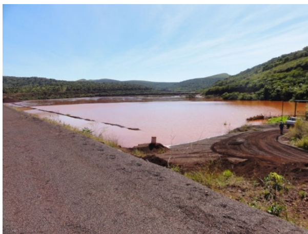
Figura 4.1.6.2.1-5. Barragem de rejeitos.
