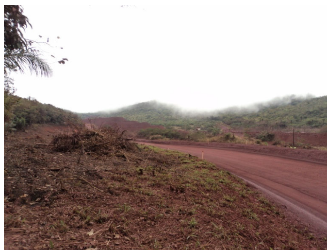
Figura 4.1.1.1.4-19. Talude de corte de estrada em jaspilitos do grupo Jacadigo
