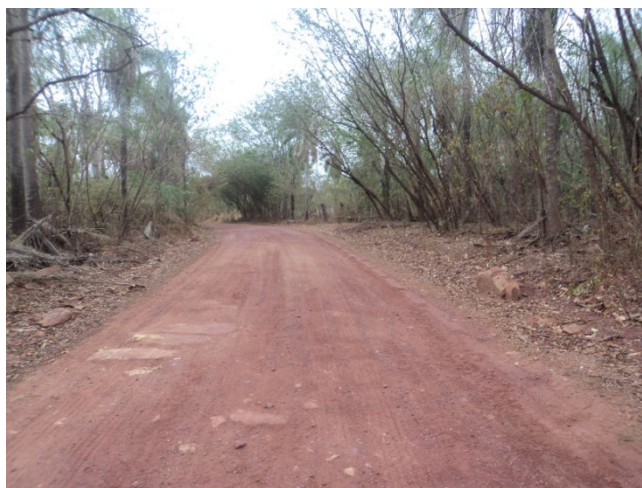
Figura 4.1.1.1.4-14. Vista da área
