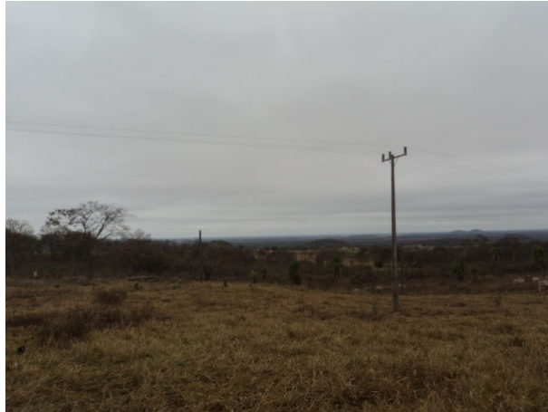
Figura 4.1.4.2.3-4 . Ponto 4 - Vista geral de uma rampa característica deste setor
