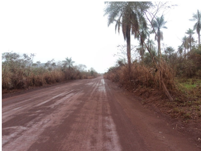
Figura 4.1.1.1.4-15. Vista da área
