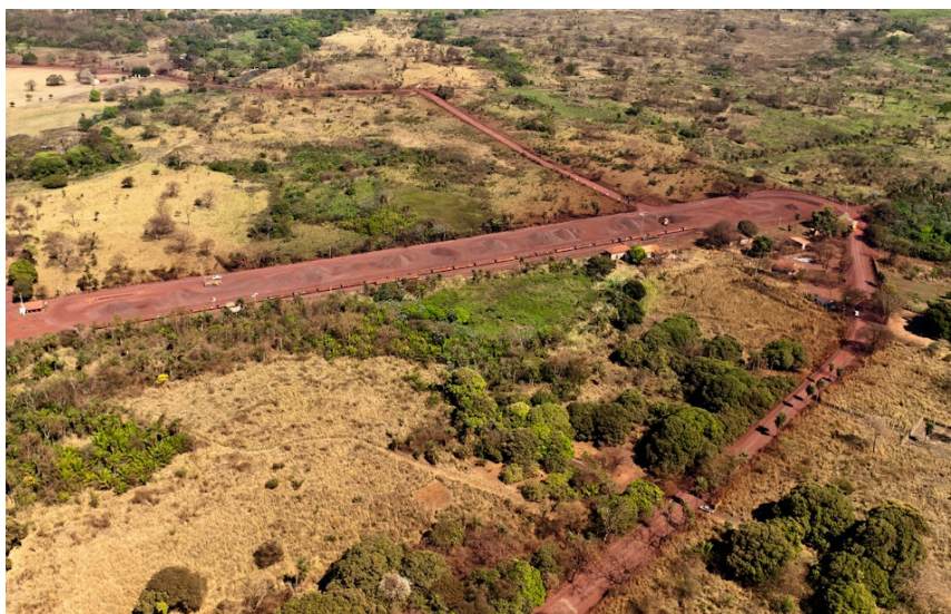
Figura 2.2.5-5: Vista aérea do Pátio de Produto e Terminal Ferroviário Antônio Maria Coelho – AMC - (Corumbá) utilizado atualmente pela MCR. Típico pátio para embarque de minério de ferro em vagões.
