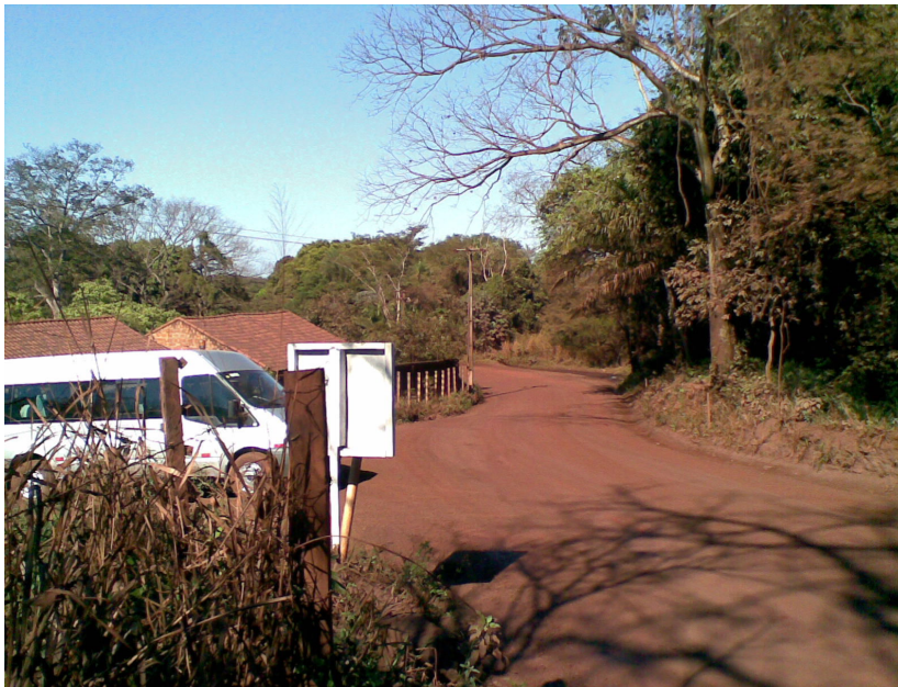
Figura 2.2.3.1-7: Estreitamento de plataforma em frente ao Balneário Lago Azul
