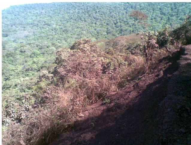
Figura 2.3.3-1: Vista da encosta à direita da estrada existente
