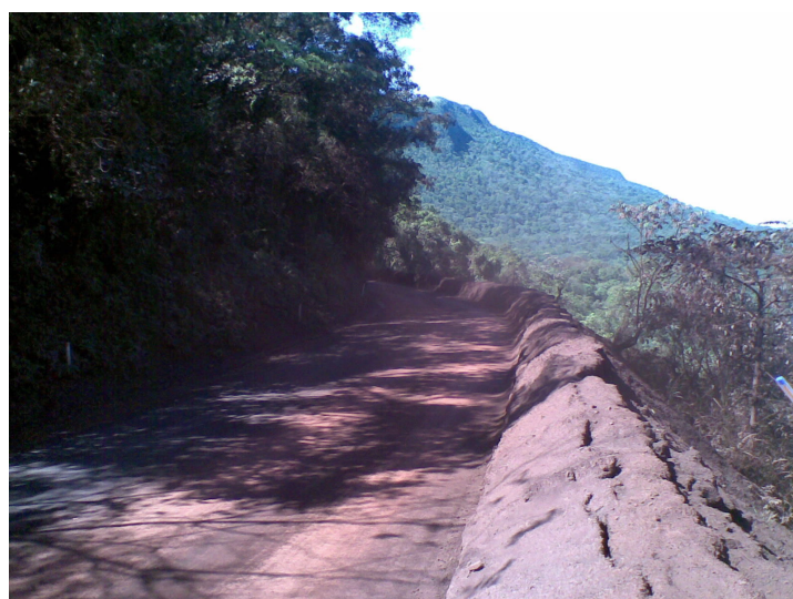
Figura 2.3.3-2: Local de Implantação do Muro de Contenção Atirantado
