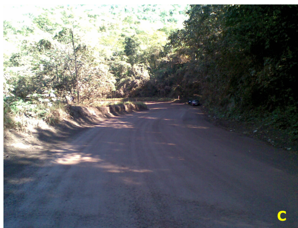
Figura 2.3.3-4: (A) Vista da Curva do Urubu, (B) Rampa acentuada na Curva do Urubu e (C) Rampa acentuada descendente, sentido exportação, após a Curva do Urubu
