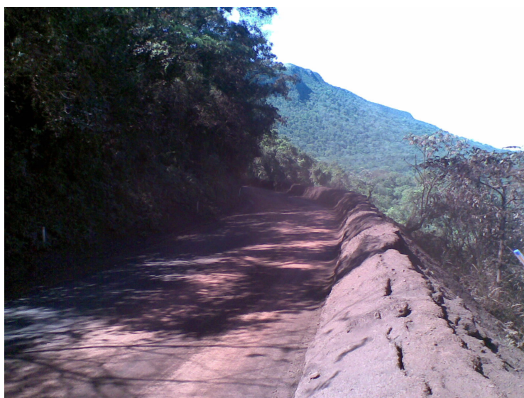
Figura 2.2.3.1-2: Local de Implantação do Muro de Contenção Atirantado.
