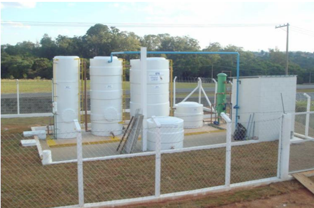
Figura 2.2.1.13.3.1-1: Modelo de ETE compacta em fibra
