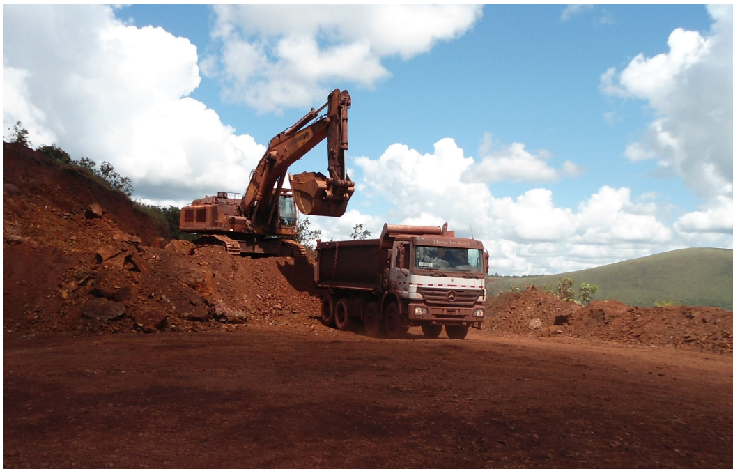
Figura 2.2.2.1-3: Operação atual na frente de lavra na MCR.
