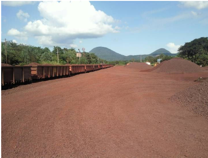
Figura 2.2.4-1: Pátio Antônio Maria Coelho – Vista da área de carregamento – A nova linha do pátio está localizada a 70,0 m da via existente, no lado direito da foto .
