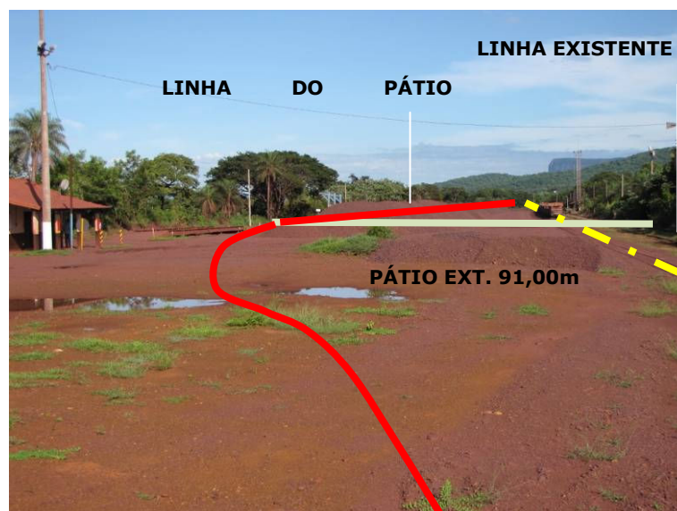
Figura 2.2.4.1.1-2: Pátio de Carregamento
