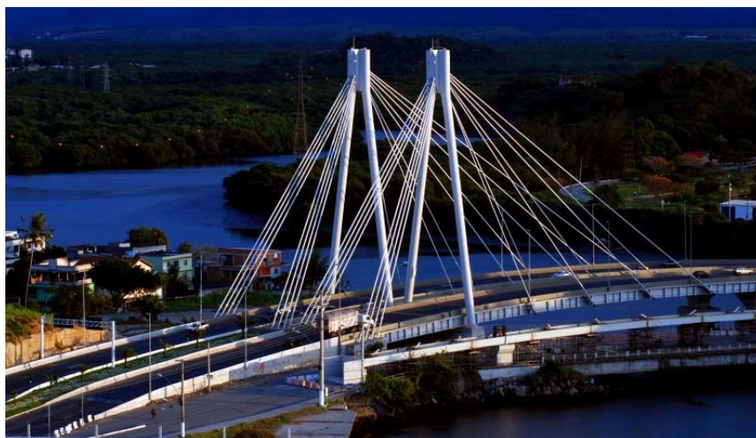
Figura 6.3-6: Nova ponte da Passagem.
