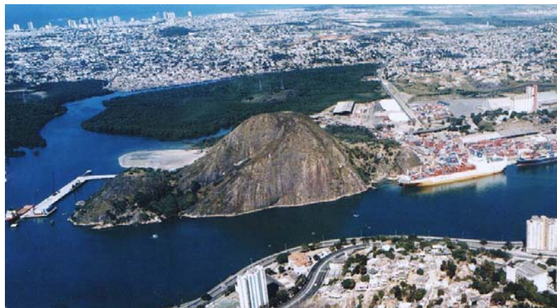
Figura 6.3-1: Porto de Vitória e de Capuaba em Vila Velha.
