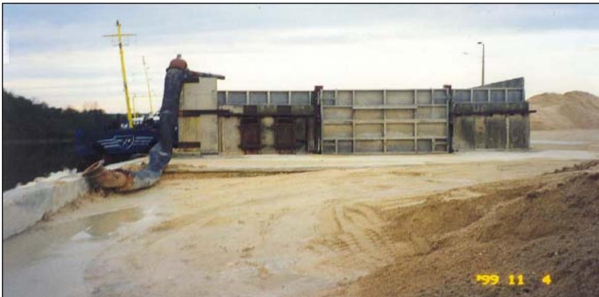
**Figura 15:** Exemplo de caixa de decantação para descarregamento hidráulico de sedimento biodetrítico marinho na Bretanha – França.
