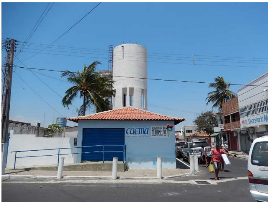
Figura 58. Sede da CAEMA, Centro/Tutóia.
