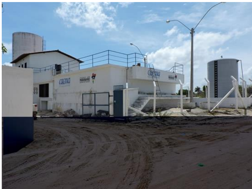
Figura 59. Estação de Tratamento de Água de Tutóia. Fonte: Disponível em http://caema.ma.gov.br/portalcaema
