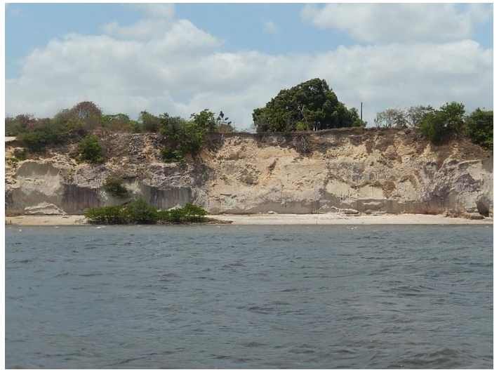
Figura 5.3.12.2-26: Falésia. Fonte: DPG Consultoria, 2018.
