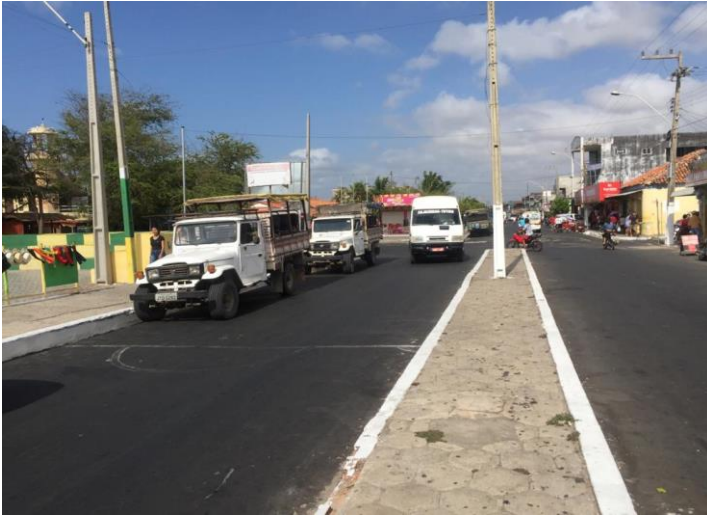
Figura 5.3.11.1-6: Vias asfaltadas. Fonte: DPG Consultoria, 2018.
