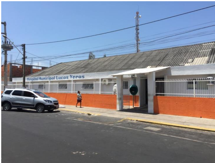
Figura 5.3.8-3: Hospital Municipal Lucas Veras. Fonte: DPG Consultoria, 2018.
