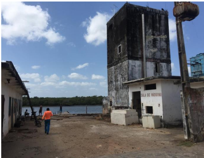
Figura 5.3.11.2-10: Fábrica de gelo. Fonte: DPG Consultoria, 2018.
