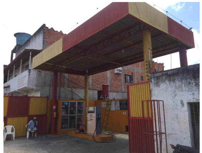
Figura 5.3.11.2-11: Posto de combustível. Fonte: DPG Consultoria, 2018.
