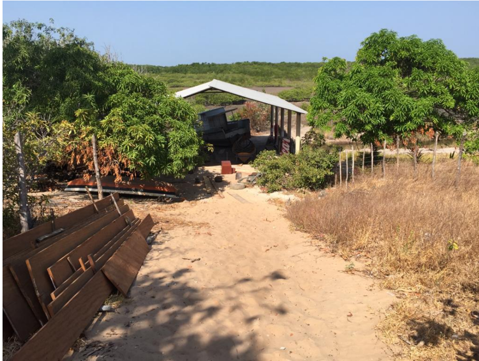
Figura 5.3.12.6-6: Galpão de construção e reparos de embarcações em Tutóia. Fonte: DPG Consultoria, 2018.
