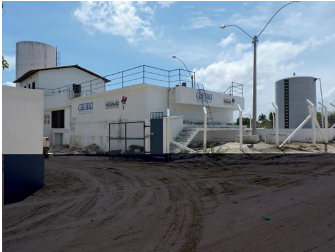
Figura 5.3.9.1-2: Estação de Tratamento de Água de Tutóia. Fonte: Disponível em http://caema.ma.gov.br/portancaema . Acesso em 12/12/2018.
