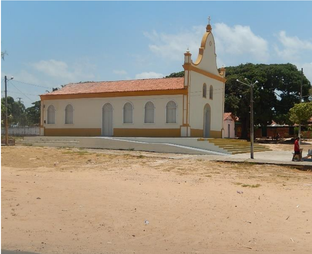
Figura 5.3.4.2-3: Igreja de Nossa Senhora da Conceição. Fonte: DPG Consultoria, 2018.
