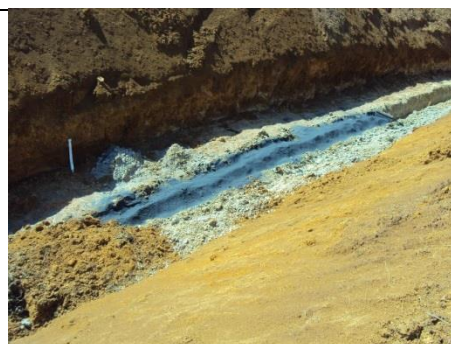
Figura 7 – Vala com o coque aplicado
