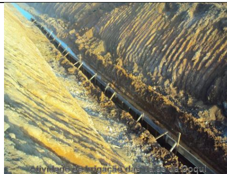
Figura 9 – Abertura de canaleta para instalação dos elementos de Fe-Si
