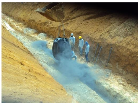
Figura 6 – Aplicação do coque
