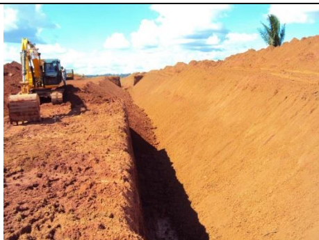
Figura 4 – Escavação (talude)
