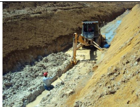
Figura 5 – Escavação (abertura da vala)
