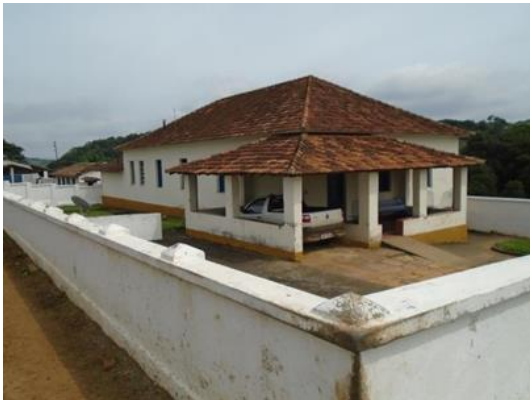
Figura 4-7 – Casa. Fazenda Terra Quebrada. Município de São Vicente de Minas.
