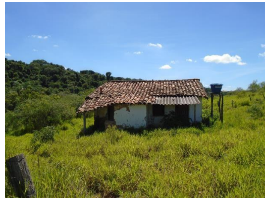
Figura 4-24 – Casa abandonada. Fazenda Joaquim Araújo. Município de São Vicente de Minas.
