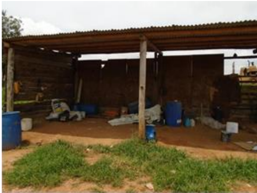
Figura 4-13 – Cobertura rústica. Fazenda. Município de São Vicente de Minas.
