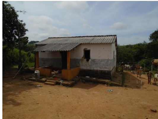
Figura 4-10 – Casa. Fazenda terra Quebrada. Município de São Vicente de Minas.
