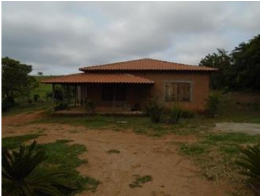
Figura 4-4 – Casa. Fazenda Pitangueiras. Município de São Vicente de Minas.
