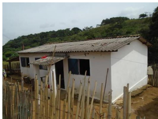
Figura 4-12 – Casa. Fazenda terra Quebrada. Município de São Vicente de Minas.
