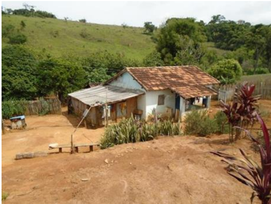
Figura 4-9 – Casa. Fazenda terra Quebrada. Município de São Vicente de Minas.
