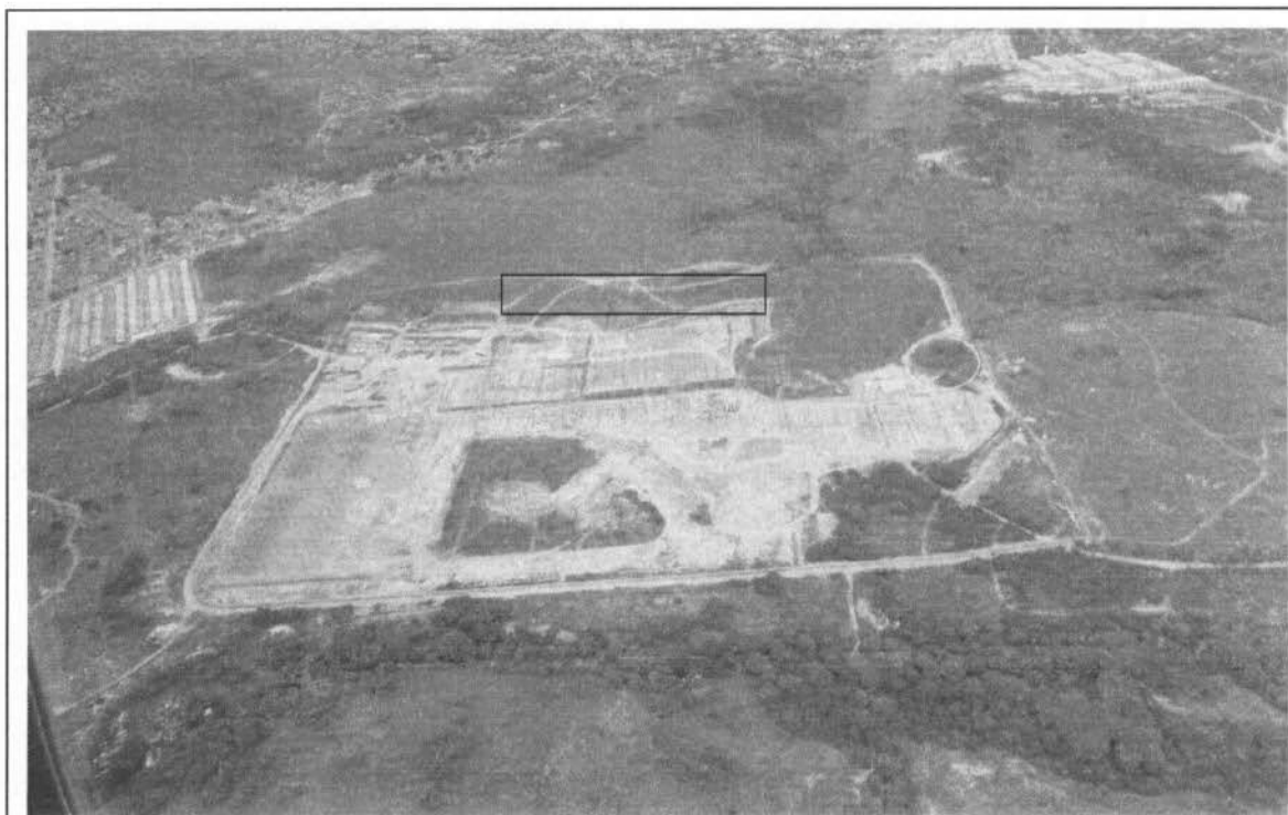
Figura 3 - SE Nova Iguaçu com destaque em preto para área de ampliação da XRTE, inclusive a presença de açude. Destaque em amarelo para a APP. Fonte: COEND.
