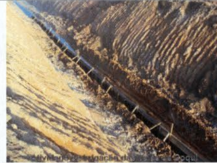
Figura 9 – Abertura de canaleta para instalação dos elementos de Fe-Si
