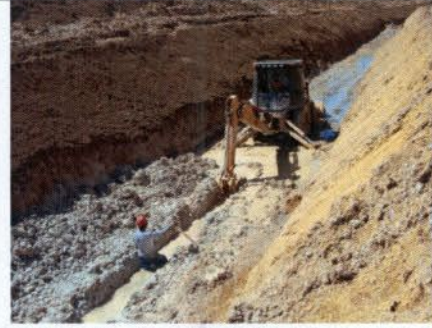
Figura 5 – Escavação (abertura da vala)
