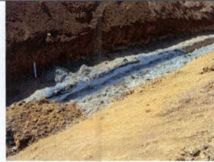
Figura 7 – Vala com o coque aplicado
