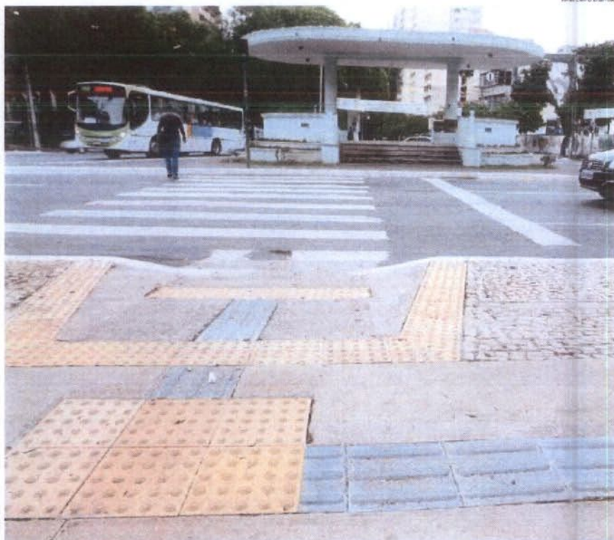
SEM CONTINUIDADE Um dos problemas de acessibilidade detectados no local: de um lado, calçada rebaixada; do outro, meio-fio normal
