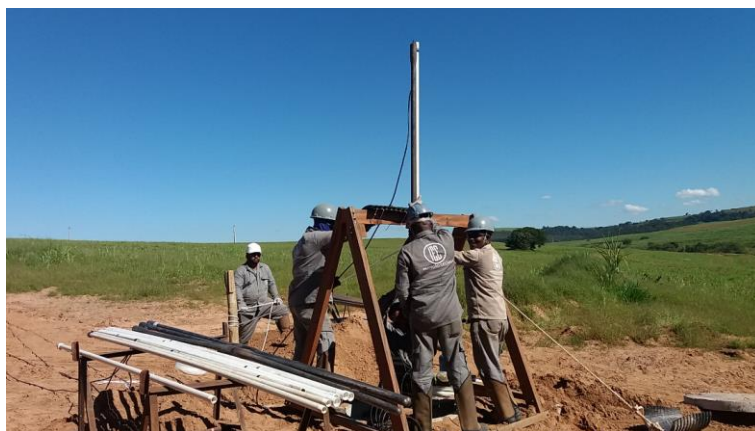
Figura 9.6 - Lançamento dos componentes internos dos poços.
