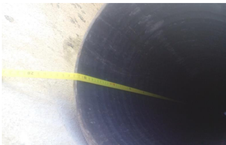
Figura 9.5 - Confirmação da Profundidade do poço para instalação dos componentes internos
