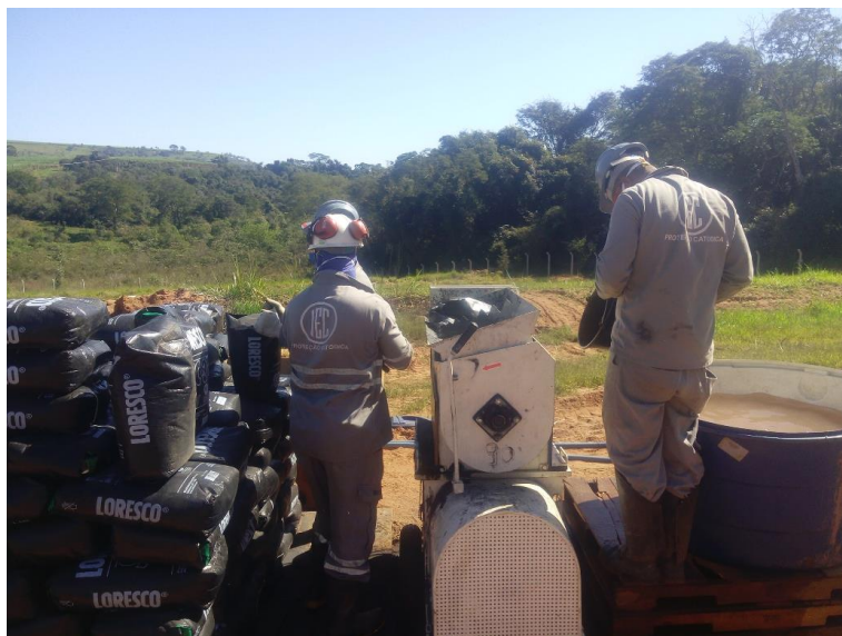
Figura 9.8 - Bombeamento de Coque para preenchimento dos poços.
