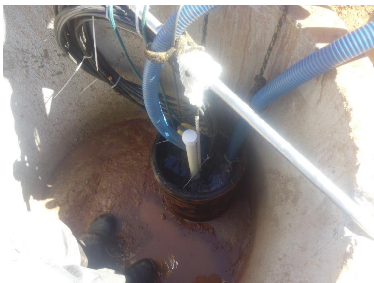
Figura 9.10 - Bombeamento de Coque para preenchimento dos poços.
