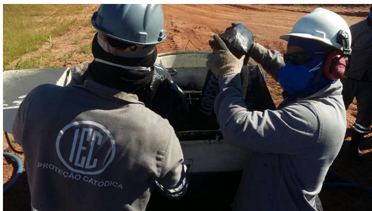
Figura 9.9 - Bombeamento de Coque para preenchimento dos poços.
