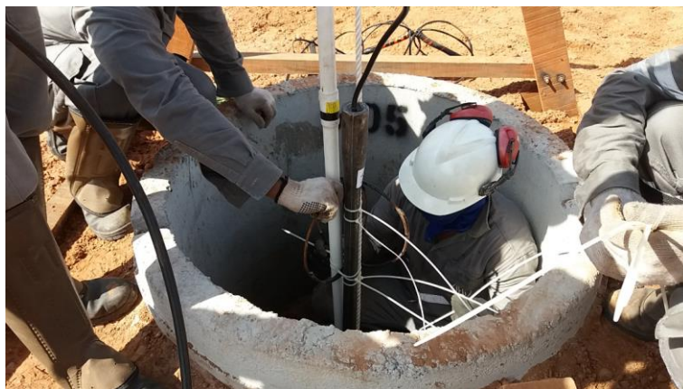
Figura 9.7 - Lançamento dos componentes internos dos poços.
