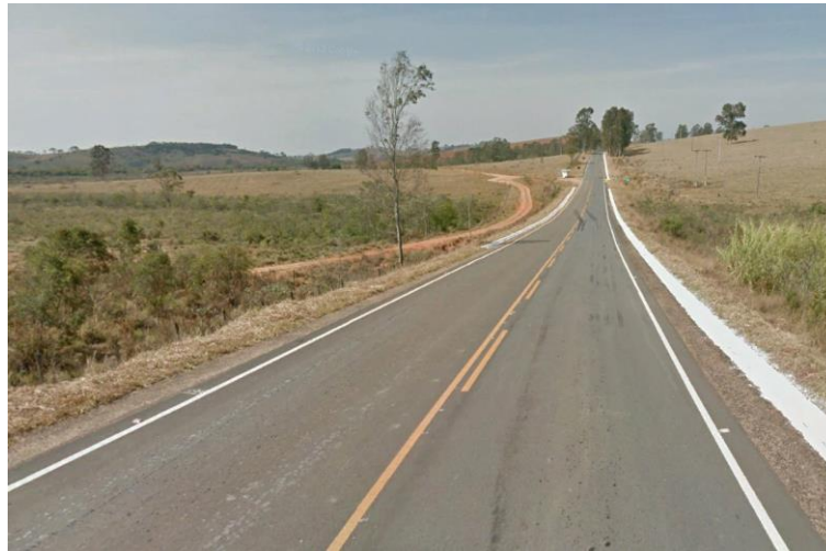
Figura 3.3 – BR-383 próximo da saída da estrada de terra.
