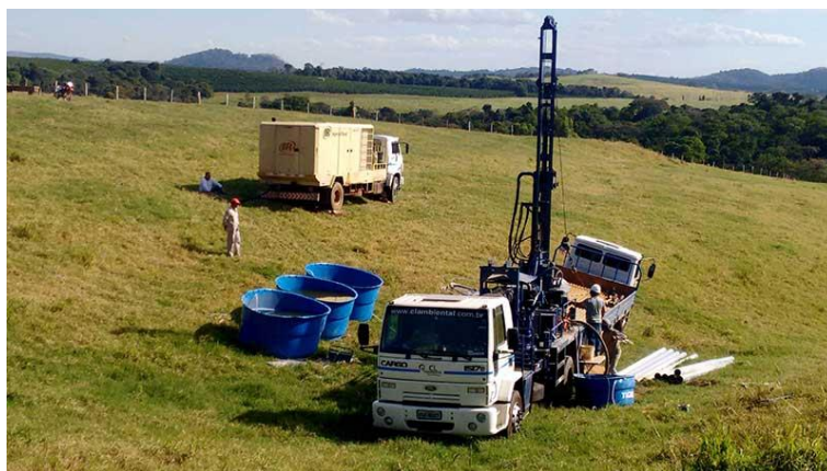
Figura 9.4 - Exemplo de equipamento para perfuração de poço profundo
