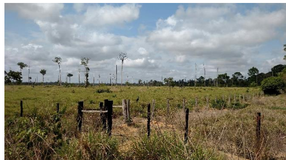
Figura 4-135 – Porção oeste do município de Senador José Porfírio onde a LT Eletrodo está inserida (UTM: 3,015483°S 51,630188°W).
