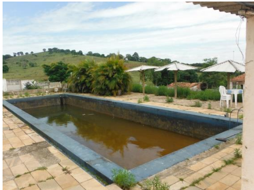
Figura 3-91 - Instalações do Espaço Z. Município de São Vicente de Minas.
