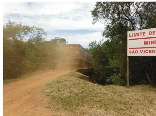
Figura 3-78 - Ponte sobre o Ribeirão das Pitangueiras, divisor natural dos municípios de São Vicente de Minas e Minduri.
