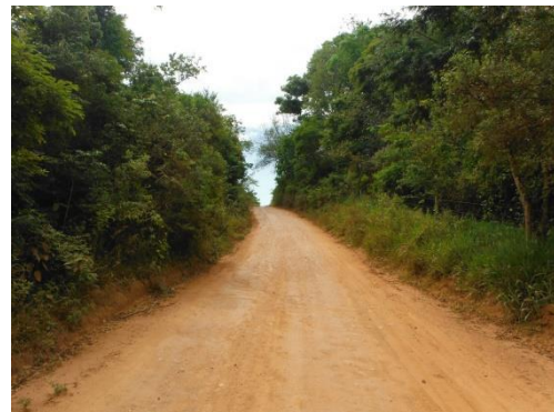
Figura 3-90 - Estrada de terra que interliga São Vicente de Minas a Carrancas. Município de São Vicente de Minas.
