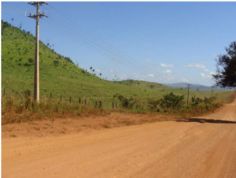
Figura 3.4.2a. Rodovia Típica do Pará, Município de Curionópolis, Próximo ao MV-52.
