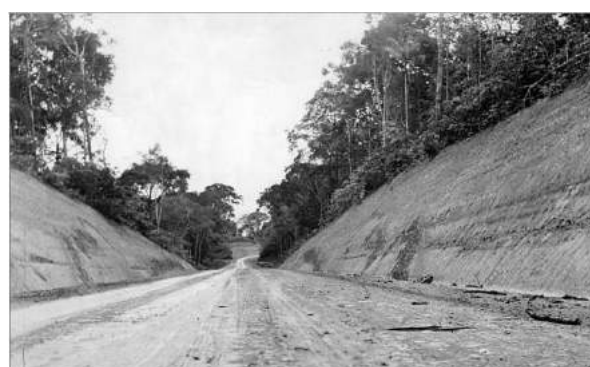
Figura 6.5.1-9 - Trecho de desmatamento para construção da Rodovia Transamazônica. 11/2/1967. Fonte: FSP, 2015.
