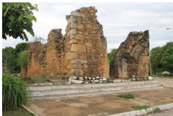
Figura 6.5.2-165 - Ruínas da Igreja de Nossa Senhora do Rosário, fachada. Acervo: Scientia Consultoria Científica: Thiago Guerra, 24.11.2015.
