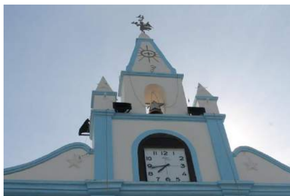
Figura 6.5.2-90 - Igreja Nossa Senhora dos Remédios, detalhe da torre sineira e do relógio. Acervo: Scientia Consultoria Científica: Thiago Guerra, 26.11.2015.
