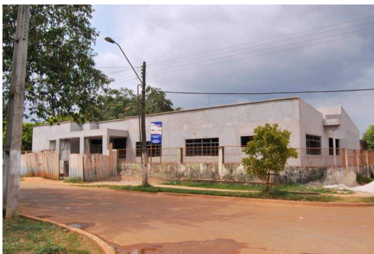
Figura 6.5.3-9 - Centro de Tradições Norte/Nordeste em construção, Novo repartimento. Acervo: Scientia Consultoria Científica: Felipe Matos, 11/2015.
