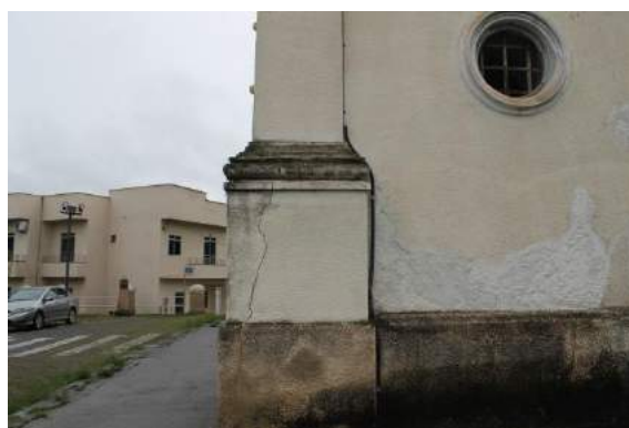
Figura 6.5.2-239 e Figura 6.5.2-240 - Igreja de Sant'Ana. Detalhe da fissura na parede. Acervo: Scientia Consultoria Científica: Thiago Guerra, 20.1.2016.
