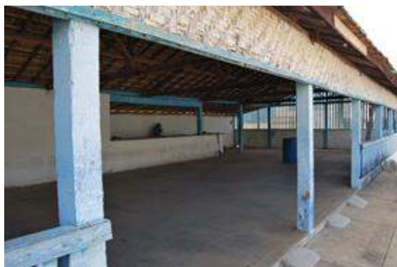
Figura 6.5.3-128 - Galpão onde funciona a cozinha para a celebração da congada do Catupé no Sindicato Rural e Centro de Evento de Bambuí/MG. Acervo: Scientia Consultoria Científica: Gustavo Fernandes, 12.2015.
