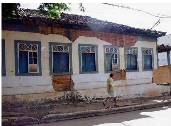
Figura 6.5.2-204 - Casarão do início do século XIX, antes do início da restauração. Fonte: http://wikimapia.org/9642510/pt/Casar%C3%A3o-hist%C3%B3rico (acesso: 16.12.2015).
