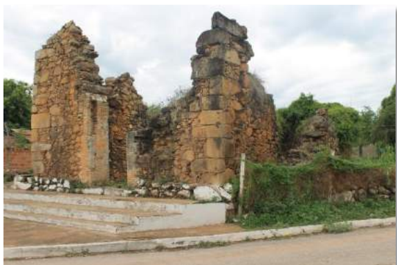
Figura 6.5.2-162 - Ruínas da Igreja de Nossa Senhora do Rosário, fachada. Acervo: Scientia Consultoria Científica: Thiago Guerra, 24.11.2015.
