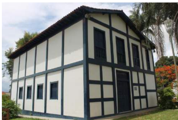
Figura 6.5.2-142 - Centro Histórico de Paracatu, réplica da Igreja de Sant'Anna, demolida em 1935. Acervo: Scientia Consultoria Científica: Thiago Guerra, 29.11.2015.
