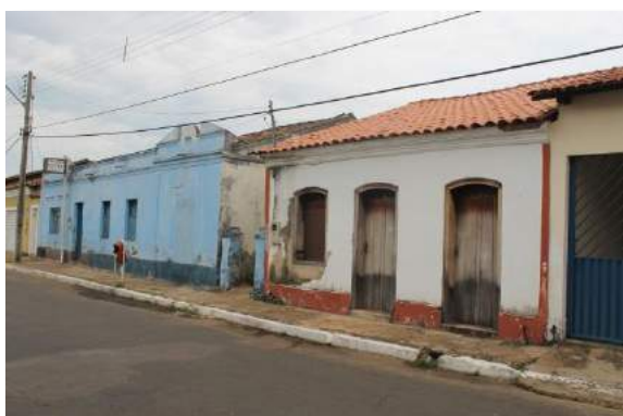
Figura 6.5.2-36 - Casario da Rua Francisco Ayres da Silva. Acervo: Scientia Consultoria Científica: Thiago Guerra, 24.11.2015.
