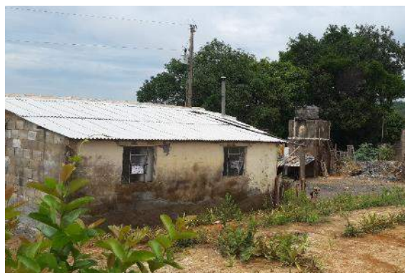
Figura 6.4.11-10 – Casa de baixo padrão construtivo localizada na faixa de servidão. Município de Córrego Danta, MG.
