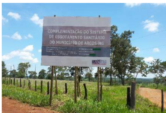
Figura 6.4.9-138 – ETE em construção. Município de Arcos, MG.
