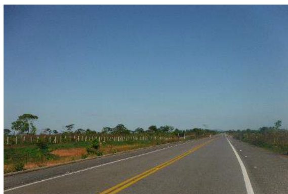
Figura 6.4.9-55 – Passagem da LT pela BR 242. Município de Paranã, TO.
