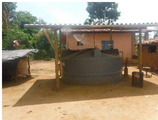
Figura 6.4.12-14 – Cisterna - Projeto Água Para Todos. Comunidade Malhadinha. Município de Brejinho de Nazaré, TO.
