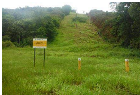
Figura 6.4.9-200 – Dutos da TRANSPETRO no bairro do Saudoso. Município de Paracambi, RJ.
