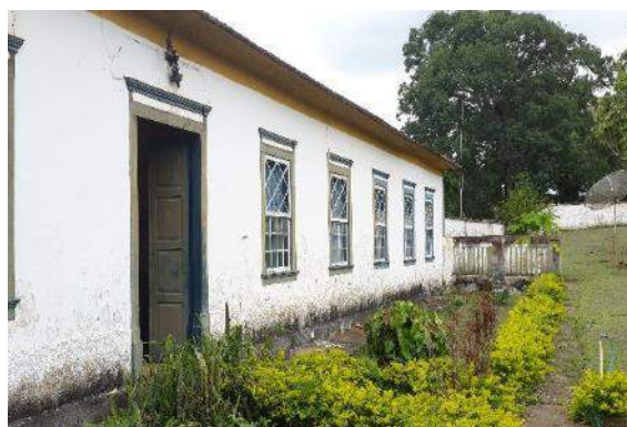
Figura 6.4.9-174 – Fachada da Fazenda Laranjeiras. Município de Andrelândia, MG.
