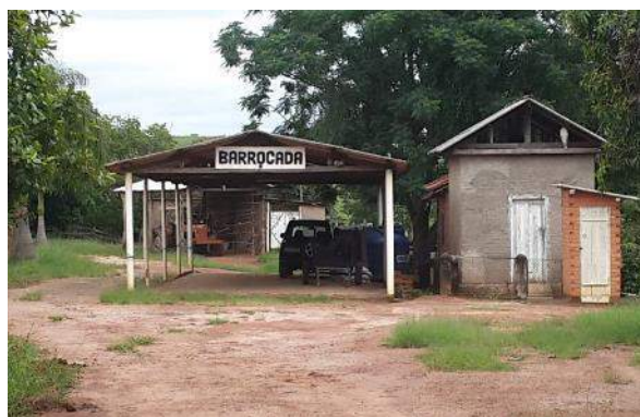
Figura 6.4.11-13 – Galpão afetado. Município de Andrelândia, MG.
