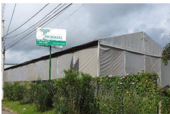
Figura 6.4.9-197 – Fábrica de isopor (Tecnocell), localizada na RJ-145. Município de Pirai, RJ.
