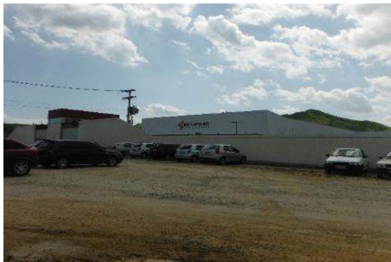
Figura 6.4.9-209 – Condomínio Industrial. Município de Paracambi, RJ.
