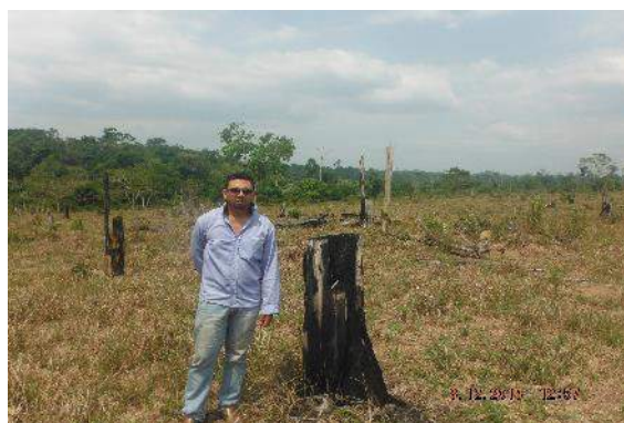
Figura 6.4.9-249 – Detalhe para destocamento incompleto no desmatamento da Fazenda Maria Carolina. Área de Instalação do Eletrodo Xingu. Município de Anapu, PA.
