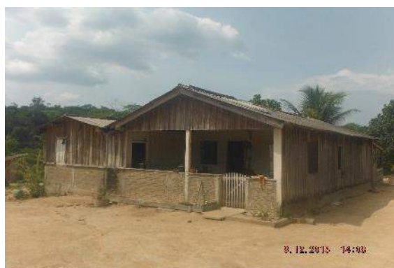
Figura 6.4.9-247 – Casa de apoio da Fazenda Maria Carolina. Área de Instalação do Eletrodo Xingu. Município de Anapu, PA.
