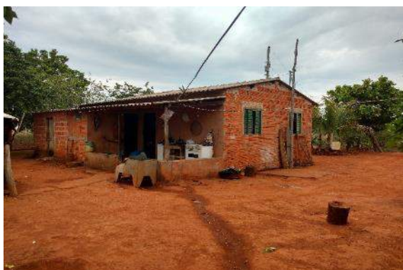
Figura 6.4.9-87 – Residência no PA União Gado Bravo. Município de Buritis, MG.
