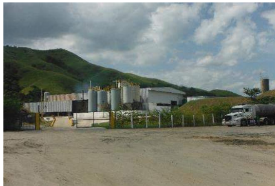
Figura 6.4.9-210 – Condomínio Industrial. Município de Paracambi, RJ.
