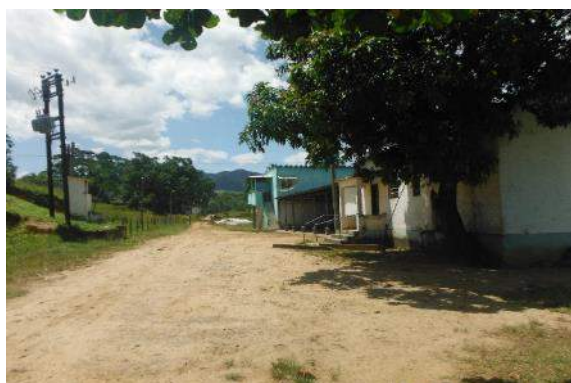
Figura 6.4.9-256 – Benfeitorias Fazenda Rio Novo. Município de Paracambi, RJ.
