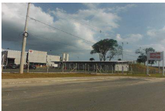
Figura 6.4.9-219 – Empresa Brasilit no bairro Santa Alice. Município de Seropédica, RJ.
