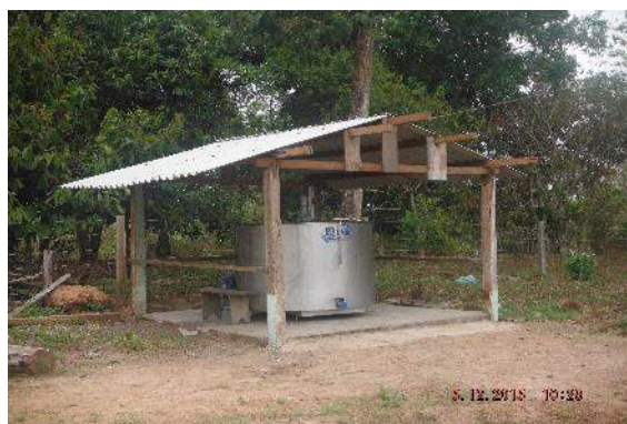
Figura 6.4.9-11 – Tanque de resfriamento de leite, que armazena a produção dos assentamentos. Município de Itupiranga, PA.
