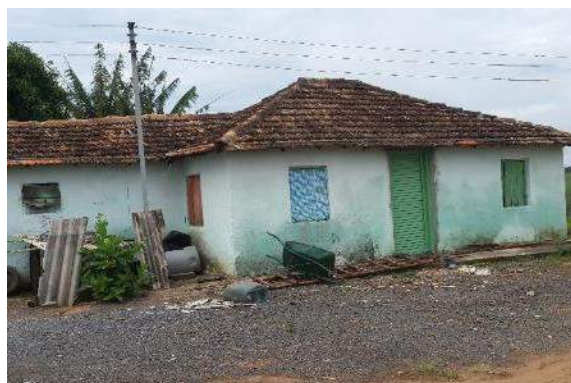
Figura 6.4.11-9 – Casa de baixo padrão construtivo localizada na faixa de servidão. Município de Córrego Danta, MG.
