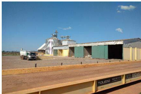
Figura 6.4.9-70 – Unidade de processamento de ração na Fazenda Paranã. Município de Iaciara, GO.
