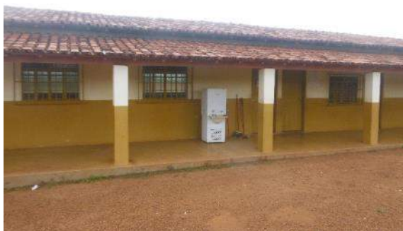
Figura 6.4.12-7 – Escola fundamental. Comunidade Malhadinha. Município de Brejinho de Nazaré, TO.
