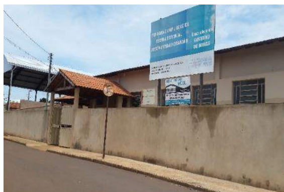
Figura 6.4.9-114 – Escola Estadual de Monjolino. Município de Patos de Minas, MG.
