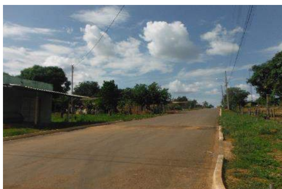
Figura 6.4.9-79 – Rua principal de Serra Bonita. Município de Buritis, MG.
