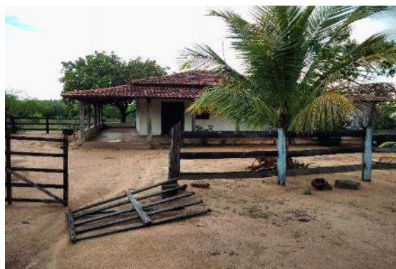
Figura 6.4.11-6 – Sede de fazenda afetada Município Santa Rosa do Tocantins, TO.
