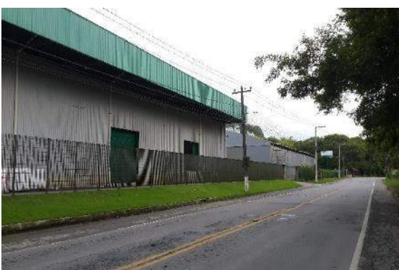
Figura 6.4.9-198 – Fábrica de isopor (Tecnocell), localizada na RJ-145. Município de Pirai, RJ.
