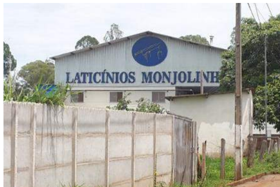
Figura 6.4.9-112 – Fábrica de laticínios. Município de Patos de Minas, MG.
