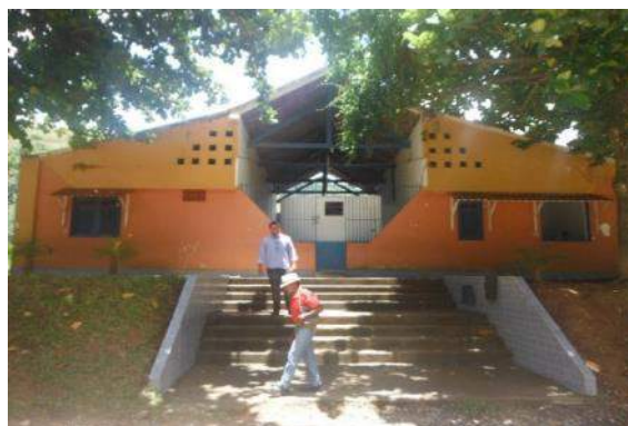
Figura 6.4.9-202 – Escola Municipal e Posto de Saúde no bairro do Saudoso. Município de Paracambi, RJ.
