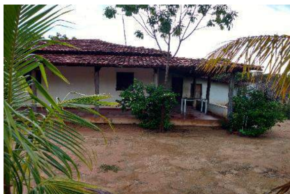
Figura 6.4.11-5 – Sede de fazenda afetada localizada na faixa de servidão. Município Santa Rosa do Tocantins, TO.
