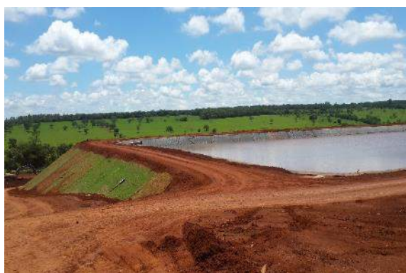
Figura 6.4.9-137 – ETE em construção. Município de Arcos, MG.
