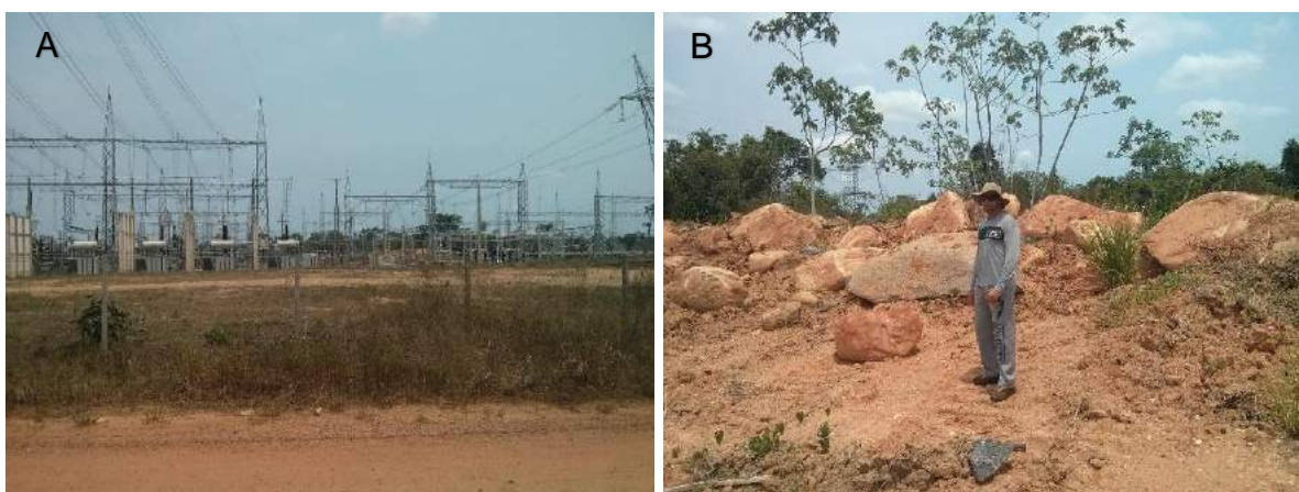
Figura 6.2.8-4 - Área da SE Xingu. (A) Vista geral da área da SE Xingu. (B) Blocos e matacões de litologias do embasamento próximos à área da SE Xingu.
