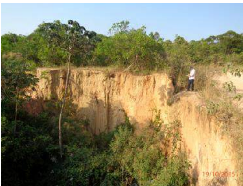
Figura 6.2.7-15- Latossolo Vermelho-Amarelo. Arcos / MG. Erosão no eixo da LT. Fonte: SOS GEO. Localização: E 449872 e N 7756740 - Elevação 842 metros.
