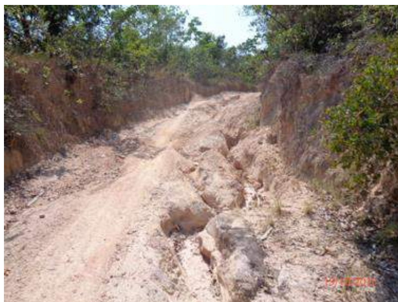
Figura 6.2.7-18- Argissolo Vermelho-amarelo. Formiga / MG. Erosão na estrada de acesso. Fonte: SOS GEO. Localização: Coordenadas E 463916 e N 7735759 = Elevação 975m.
