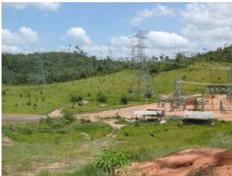
Foto 4 - Vista Geral do entorno da SE
