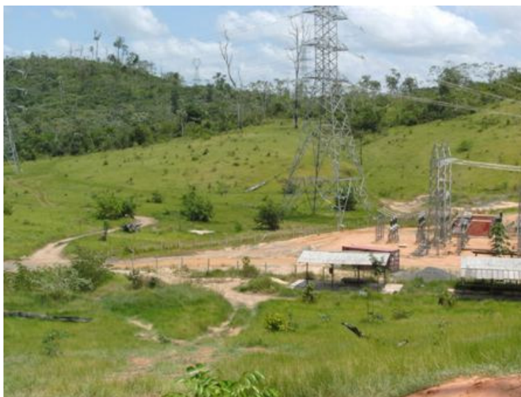
Foto 5- Vista Geral do entorno da SE
