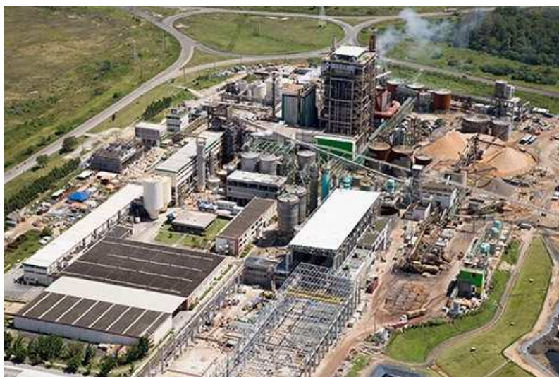
Figura 4- Vista do Parque Industrial da Jari Celulose
