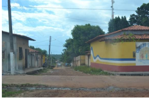
Rua em que passará a nova Linha de Subtransmissão
