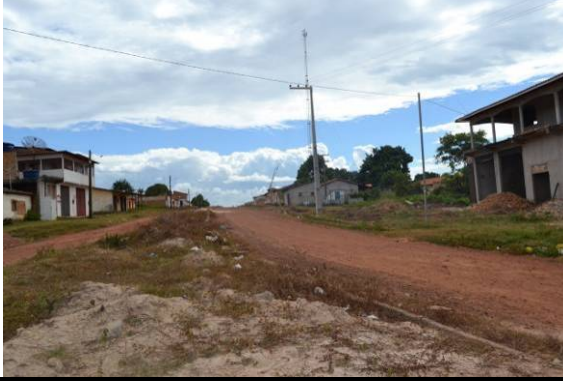
Rua sentido Mirinzal-Cururupu da nova Linha de Subtransmissão
