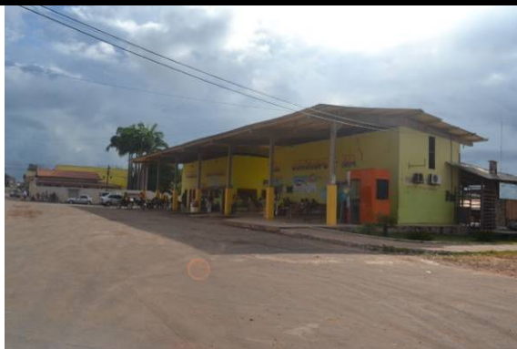
Terminal Rodoviário de Cururupu - MA
