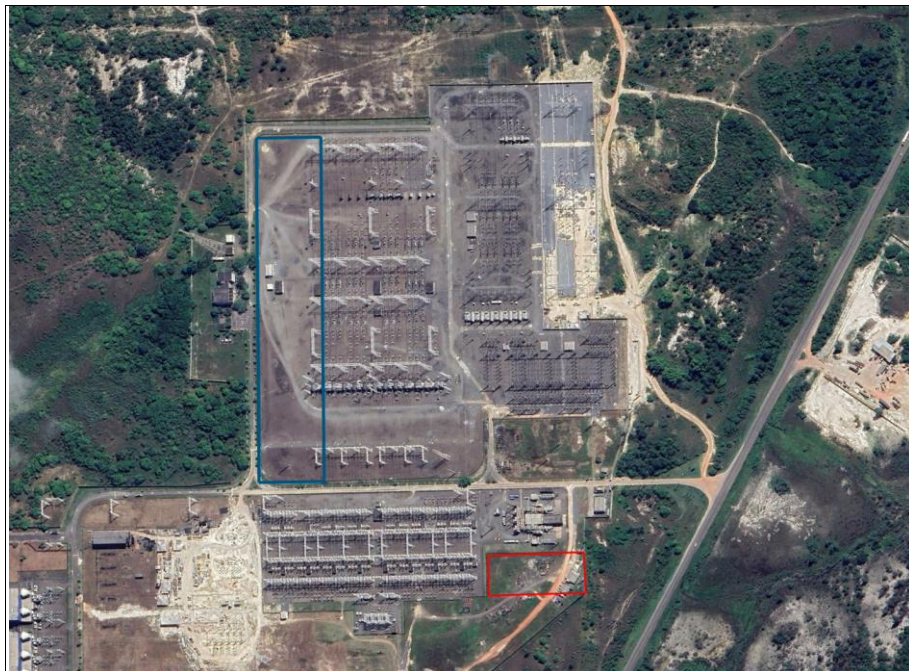
Figura 5-34 – Canteiro de Apoio Subestação Camaçari II (Dias D'Ávila).
