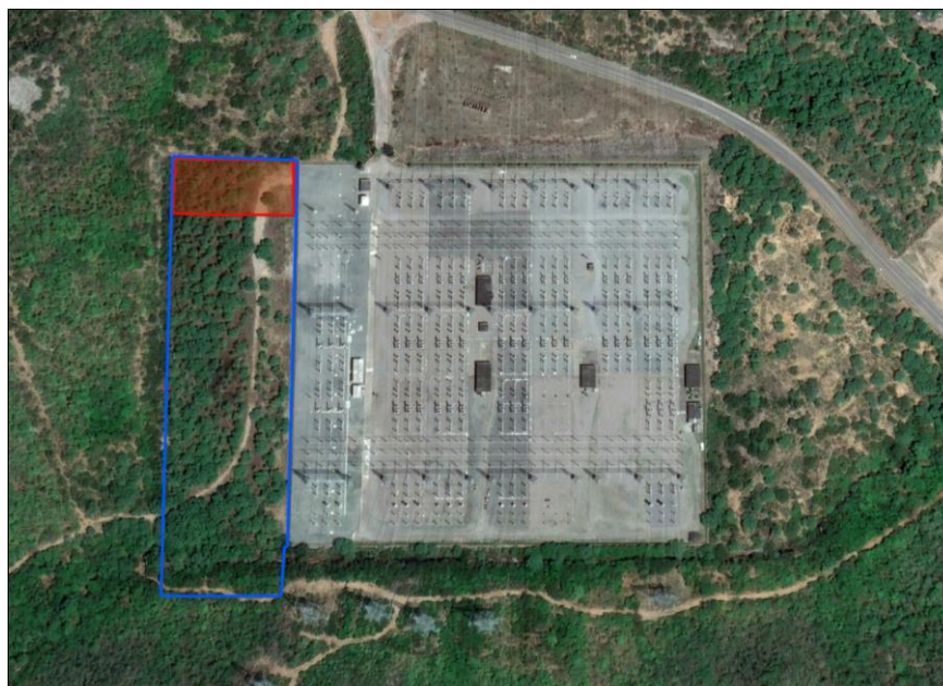
Figura 5-39 – Canteiro de Obras de Apoio Subestação Xingó (Canindé de São Francisco).
