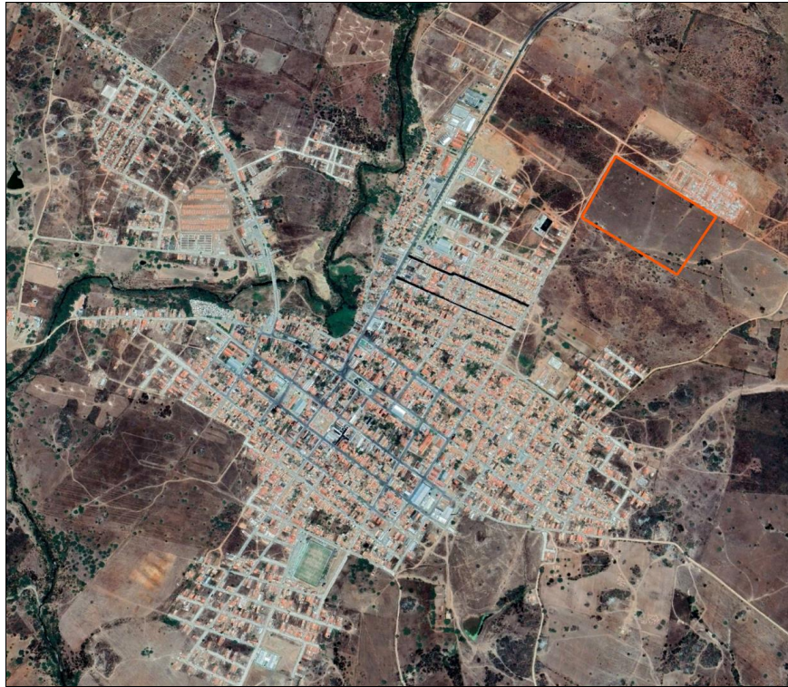
Figura 5-37 – Canteiro de Obras de Apoio 03 – Cel João Sá.
