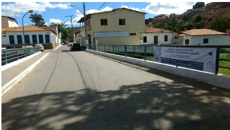
Faixa 3 – Ponte do INSS
