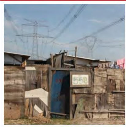
Construção de moradias e benfeitorias
