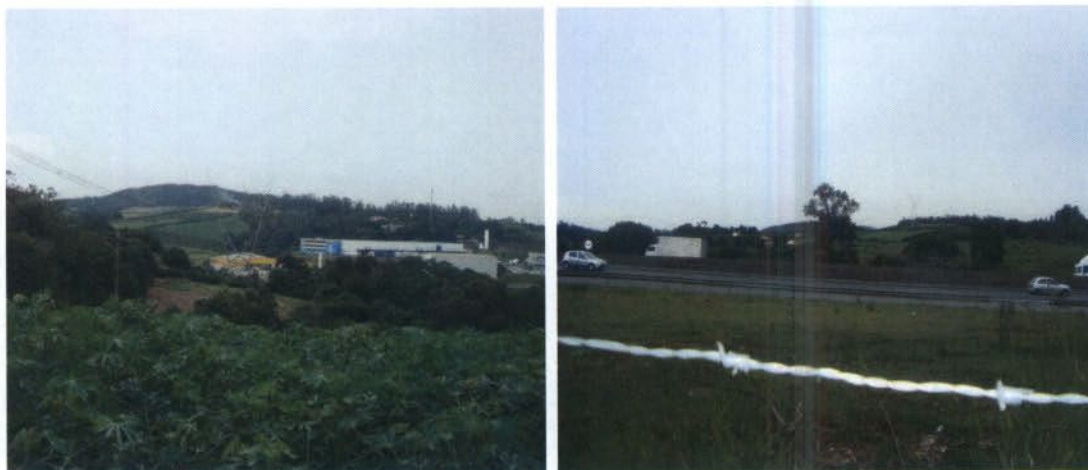
Figuras 27 e 28: Destaque para o local proposto para instalação da torre.
