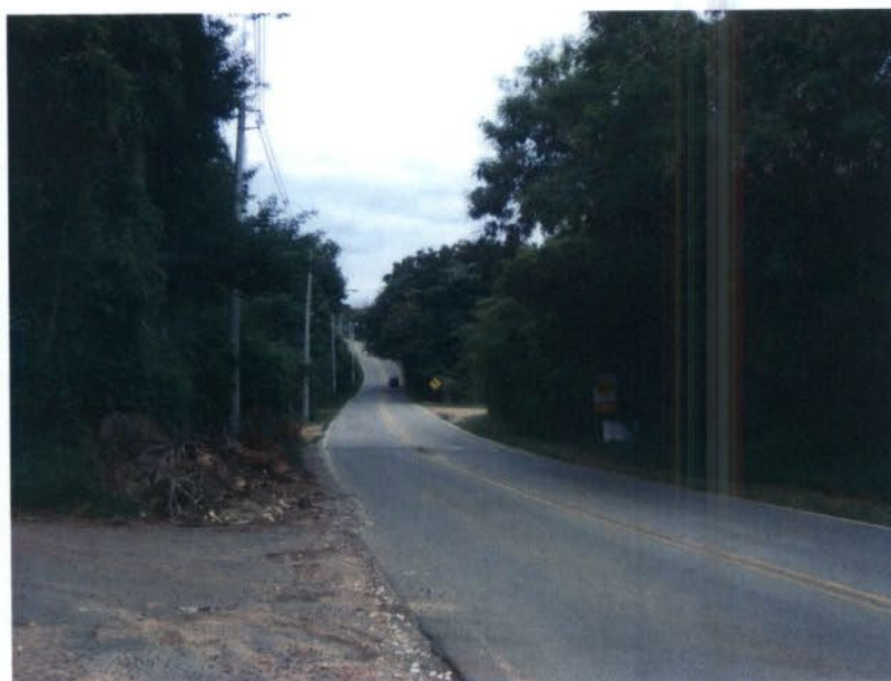
Figura 48: Destaque para o local proposto para instalação da torre.
