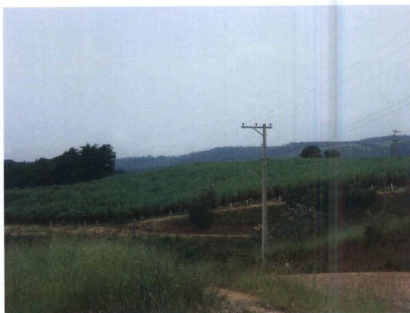
Figura 08: Destaque para o local proposto para instalação da torre.
