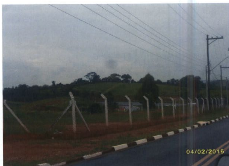
Figura 06: Destaque para o local proposto para instalação da torre.
