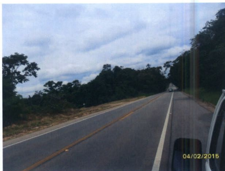
Figura 53: Destaque para o local proposto para instalação da torre.
