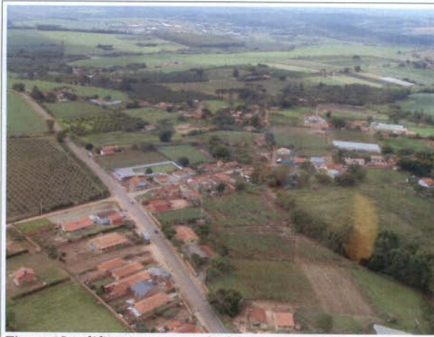
Figura 13: edificações na provável faixa de servidão ( 23°51'21.10"S 48° 9'50.34"O)
