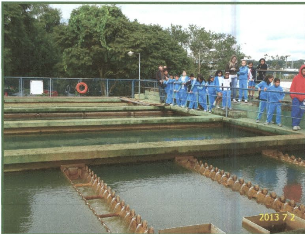
VISITA MONITORADA À ETA. EXPLANAÇÃO SOBRE AS ETAPAS DO TRATAMENTO DE ÁGUA.
