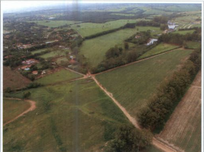
Figura 2: construções ao longo do traçado da linha (23°18'51.86"S 47°26'1.88"O)
