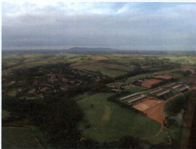
Figura 3: construções ao longo do traçado da linha ( 23°18'35.52"S 47°29'59.37"O)
