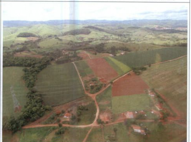
Figura 16: trecho de Itatiba-Bateias onde haverá o paralelismo de linhas ( 24° 4'20.06"S 48°21'11.97"O)
