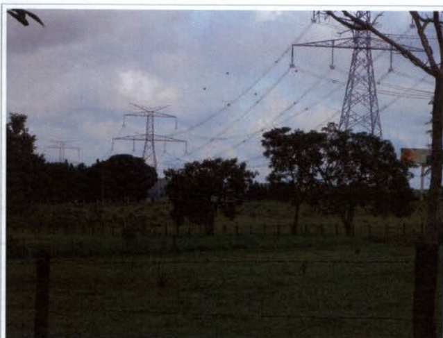
Figura 47: Propriedade visitada da Srª Iraídes que será impactada pelo paralelismo de linhas, Analândia-SP
