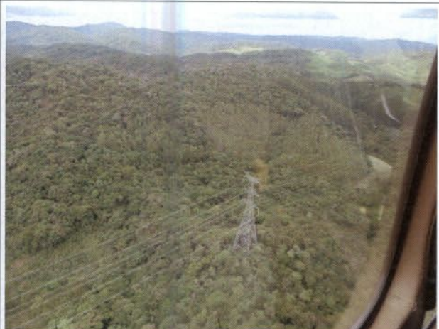
Figura 28: continuação do traçado da linha no trecho em que ocorrerá paralelismo ( 24°16'27.54"S 48°36'10.71"O)
