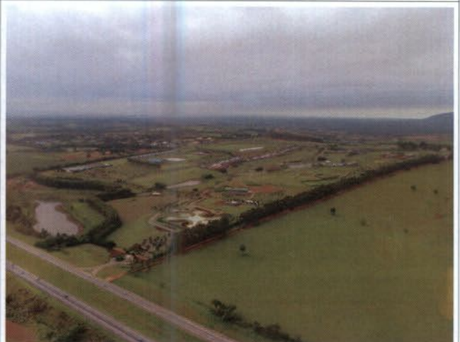
Figura 4: construções ao longo do traçado da linha ( 23°19'37.66"S 47°33'45.94"O)
