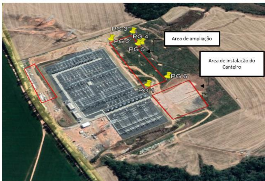
Figura 20 – SE Ponta Grossa – Área da ampliação e canteiro de obras.
