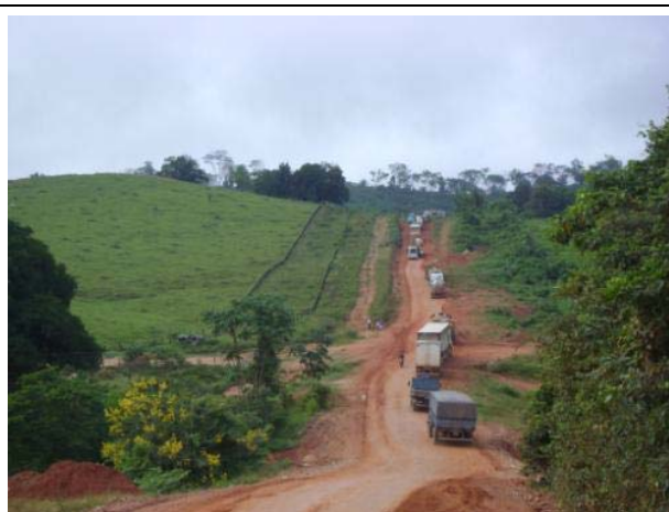
Foto 06: – Ponto 1 – município de Anapu, PA. Estrada de acesso ao município. Em épocas de chuvas a formação de atoleiros prejudica o livre trânsito
