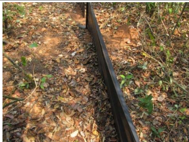
Foto 44: Detalhe da lona plástica instalada.
