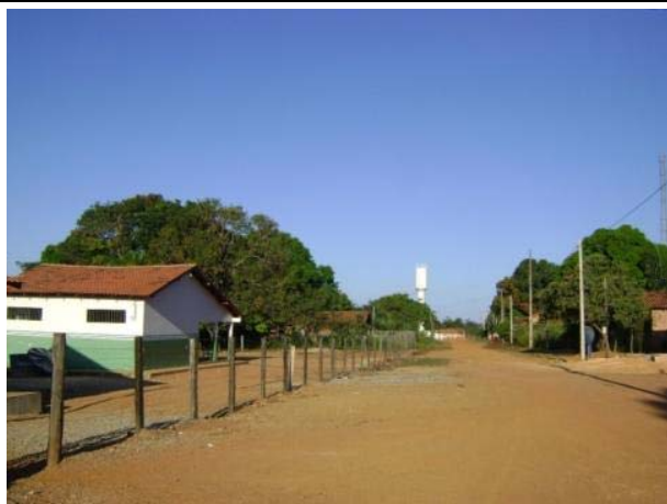
Foto 21: Ponto 4 – vila Ametista situada no município de Floresta do Araguaia, PA. Aspectos do núcleo urbano mostrando uma das ruas principais do assentamento. O rio Araguaia está situado próximo a esse ponto.
