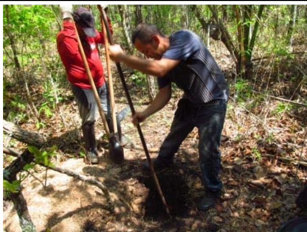
Foto 39: Uso de diferentes ferramentas (pás, enxadas) que facilitaram a abertura do buraco para a instalação da armadilha de interceptação e queda.
