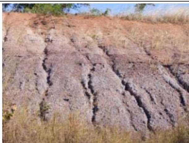
Fotos 113 e 114: Erosão em sulcos em talude de corte em argilitos da Formação Pimenteiras, que sustentam terrenos Colinosos (Cam) nas proximidades do Vértice JGP MV 4B.
