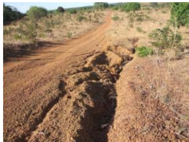
Fotos 147 e 148: Vales erosivos acumulativos com planícies fluviais estreitas e descontínuas, e processos de erosão laminar e em sulcos frequente de média a alta intensidade que ocorrem ao longo das estradas nos Terrenos Colinosos com Morrotes, nas proximidades do Vértice JGP MV 47B (Faixa 14).
