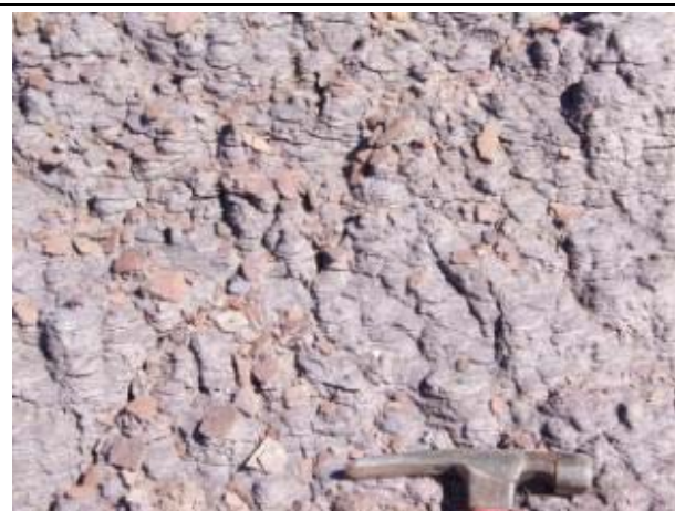
Fotos 113 e 114: Erosão em sulcos em talude de corte em argilitos da Formação Pimenteiras, que sustentam terrenos Colinosos (Cam) nas proximidades do Vértice JGP MV 4B.
