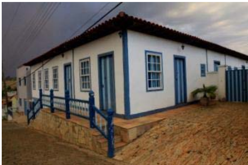
Foto 29: Vista lateral do casarão.
