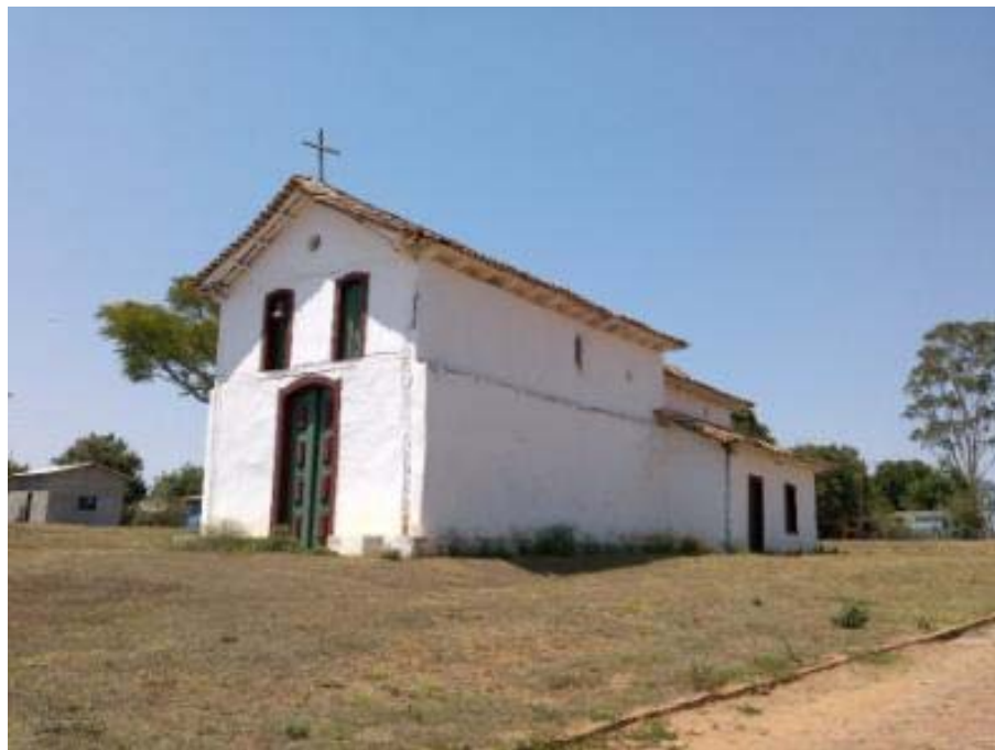
Foto 13: Igreja de Nossa Senhora do Desterro, em Desemboque, distrito de Sacramento/MG. Edificação singela, com o emprego da taipa e com o madeiramento exposto, uma característica que se estenderá pelo Triângulo Mineiro e por Goiás (Pirenópolis, Pilar de Goiás, Cidade de Goiás, etc.), indicando o ritmo e o sentido da ocupação da região central da colônia.
