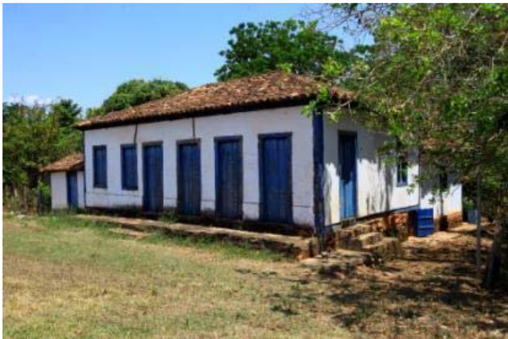
Foto 19: Moradia rural em Desemboque, novamente o emprego da taipa e do madeiramento aparente, o quintal dá acesso às áreas de cultivo, havendo uma área de transição ocupada por estruturas de criação de pequenos animais (galinhas, patos, etc.) e pomar.
