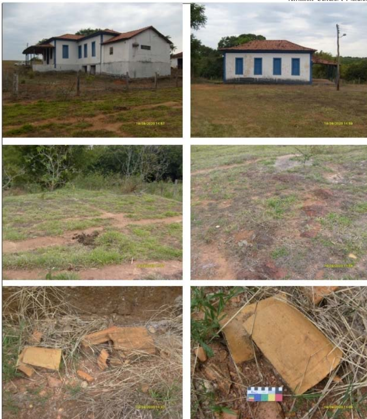
Fig. 01: Vista da fachada frontal da fazenda. Fig. 02: Vista da cozinha da sede. Fig. 03: Alicerce existente no fundo da casa. Fig. 04: Alicerce em pedra canga existente junto a cozinha Fig. 05: Fragmentos de Telha tipo capa e canal identificados próximo a casa sede.
