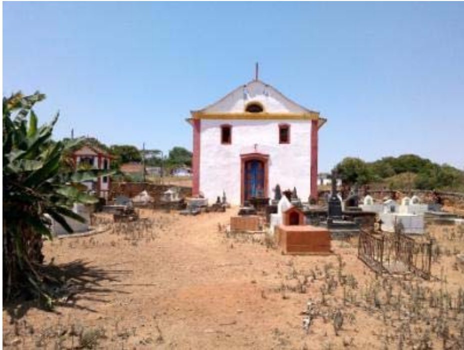
Foto 16: Absolutamente alinhada a Igreja de Nossa Senhora do Desterro, está a Igreja de Nossa Senhora do Rosário e São Benedito, cercada pelo cemitério local. A disposição das duas igrejas balizou a conformação do pequeno vilarejo e de suas estruturas urbanas. O quadrilátero era essencialmente formado pelas duas igrejas, um vasto terreno entre as duas e um grande quadrilátero circundante onde se dispunhas as casas com as fachadas para a frente e os imensos quintais (que davam caminho às áreas de plantio e pastoreio) ao fundo.
