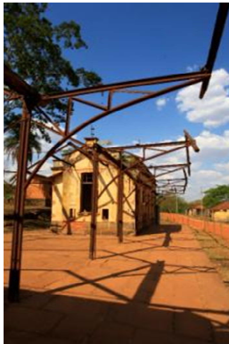
Foto 49: Plataforma da estação desativada em Sacramento/MG.
