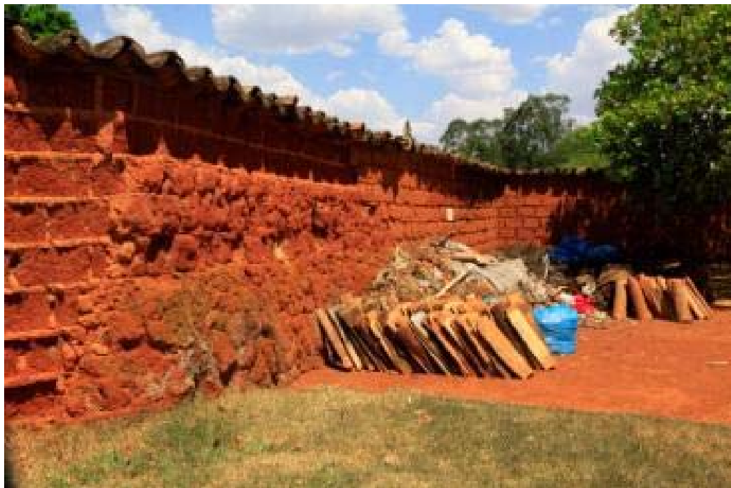
Foto 25: Material construtivo tradicional abandonado nos fundos da igreja.
