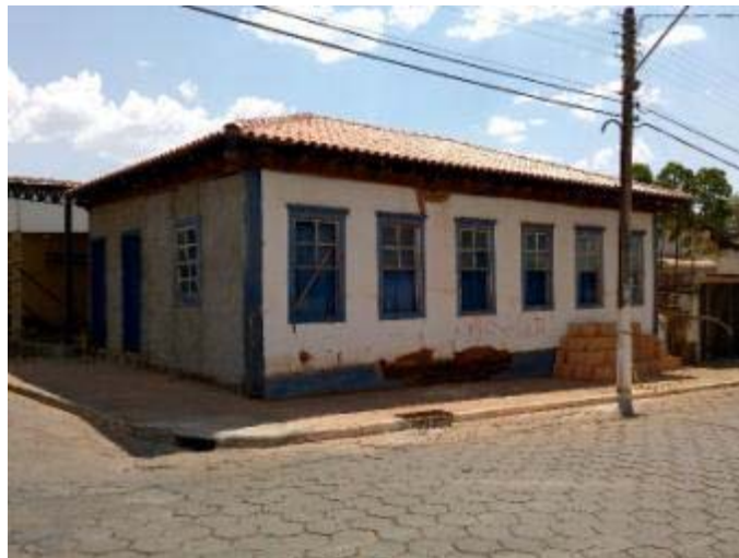
Foto 37: Casarão em Silvânia prestes a ser reformado, com a substituição do adobe tradicional pelo tijolo cerâmico.
