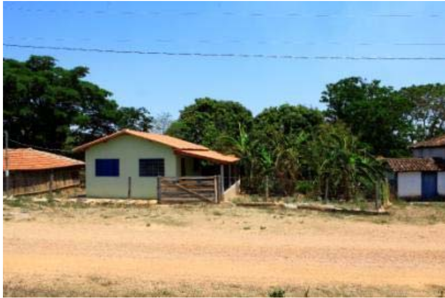
Foto 20: Contudo, a ausência de uma política mais intensa de preservação e cooperação com os moradores locais tem levado a descaracterização do que é um típico povoado de fronteira agrícola do século XVIII. Neste caso a moradia tradicional foi substituída por outra de alvenaria, a qual destoa completamente do conjunto.
