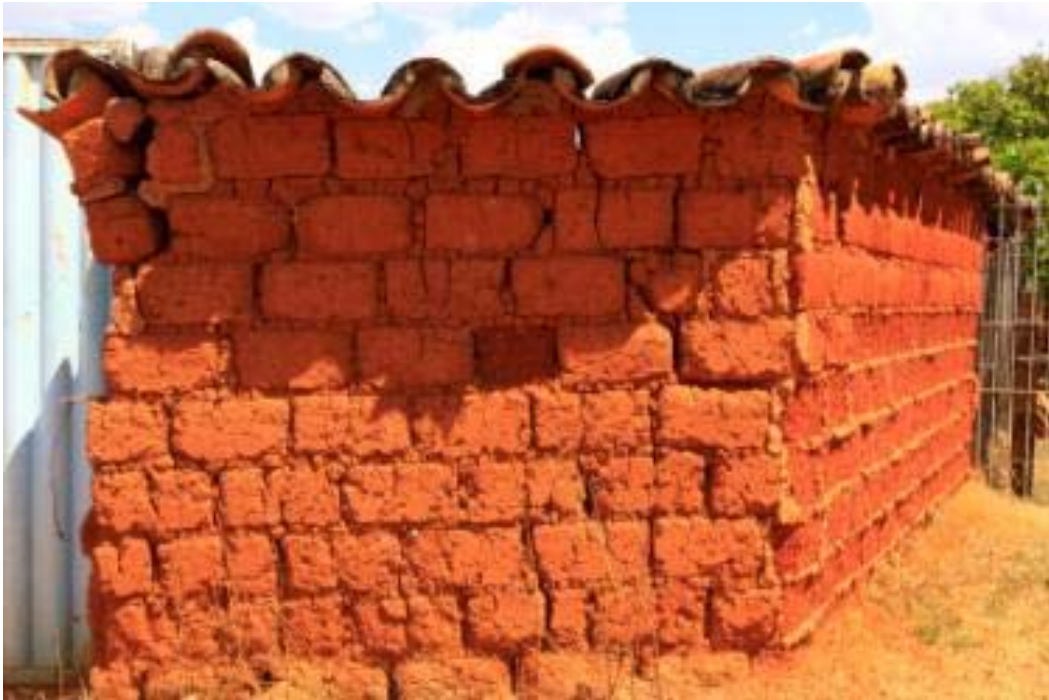
Foto 24: O adobe, empregado em todas as construções do primeiro período de Silvânia, pouco a pouco, vai desaparecendo e dando lugar a alvenaria.
