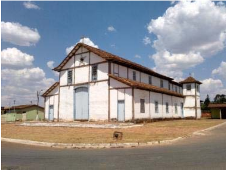
Foto 22: Igreja matriz em Silvânia/GO. Novamente o modelo construtivo de taipa com o madeiramento aparente e em blocos independentes (com travas), que lembram o modelo enxaimel de construção.
