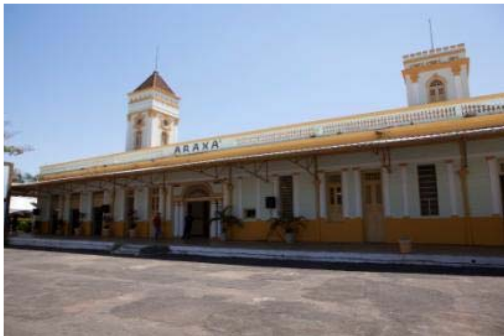
Foto 47: Construção da virada do século XIX para o XX, de caráter oficial (estação ferroviária) e marcada pela influência do ecletismo. Atualmente abriga a Fundação Cultural Calmon Barreto, onde ocorrem atividades ligadas ao artesanato e eventos anuais como a Feira Literária.
