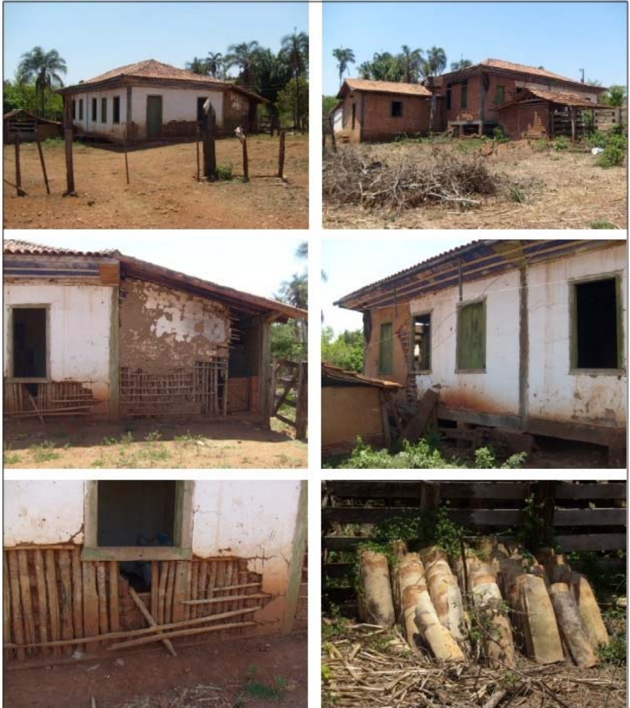
Fig. 01: Vista da frente da edificação Fig. 02: Vista do fundo da edificação Fig. 03: Vista Lateral onde pode ser observada a técnica construtiva. Fig. 04: Na lateral observa-se os beirais em madeira. Fig. 05: Detalhe de parte da parede. Fig. 06: Telha tipo capa e canal depositadas na lateral da edificação.
