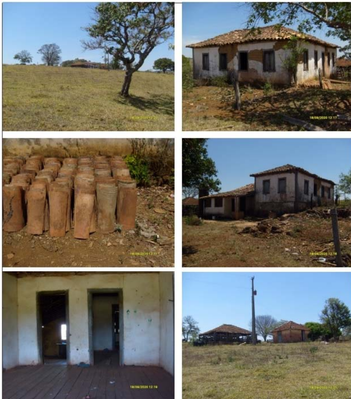
Fig. 01: Vista da AIHA a partir da estrada. Fig. 02: Vista Frontal da edificação. Fig. 03: Telhas tipo capa e canal colocadas junto a edificação. Fig. 04: Vista da cozinha nos fundos da edificação. Fig. 05: Vista interna com assoalho de madeira. Fig. 06: Estruturas anexas.
