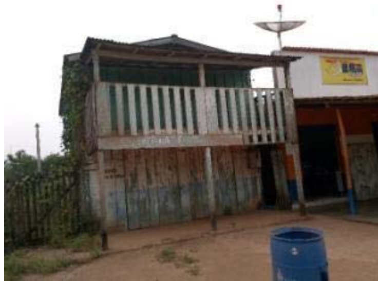
Foto 65: Apesar do emprego do Taboado, da pintura a cal, a construção recupera uma tradição secular da América Portuguesa e do Brasil: a unidade de uso misto ou compartilhado. No andar de cima a residência, no térreo a venda ou o local de prestação de serviços. Note-se que há a adaptação ao ambiente amazônico, com a vasta varanda e a pequena marquise, soluções contra o extremo calor e as chuvas constantes. Rio Vermelho/PA.
