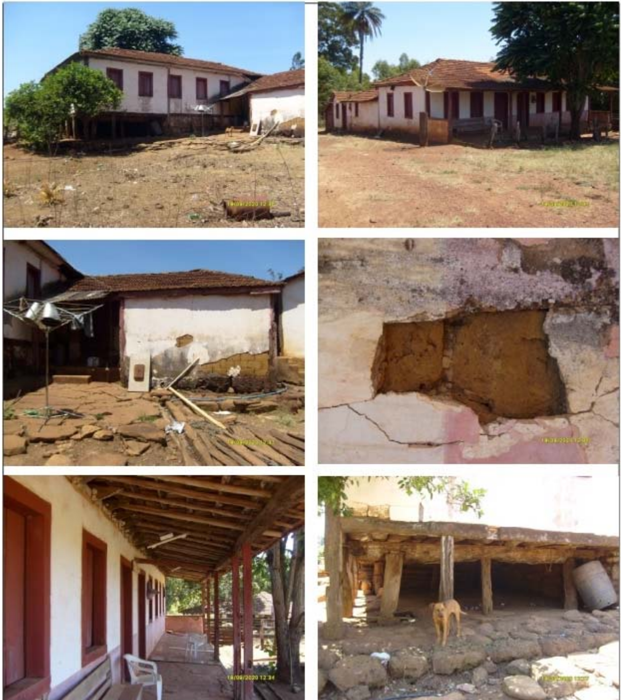
Fig. 01: Frente da edificação na porção mais elevada do terreno. Fig. 02: Fundo da edificação na parte mais baixa do terreno. Fig. 03: Vista da área de cozinha no fundo da edificação. Fig. 04: Detalhe do tijolo de adobe. Fig. 05: Varanda na entrada da edificação. Fig. 06: Alicerce de pedra lavrada.
