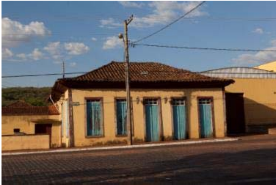
Foto 34: Casa em Sacramento/MG. Nesse caso a morfologia da construção pende mais para a arquitetura caipira, a “casa paulista” de tempos de colônia/Império, como descrito por Carlos Lemos. O arranjo de duas janelas e três portas de duas folhas permite a transição entre residência e uso comercial (venda), sempre que desejável.
