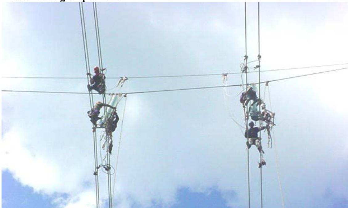
Figura 4.4.6.a Trabalhos de grampeamento
