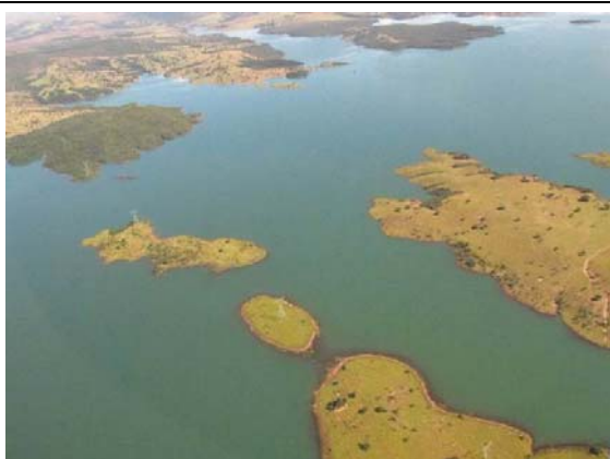
Foto 41: Detalhe do local de travessia do reservatório da UHE Corumbá IV pela Macrodiretriz 3.
