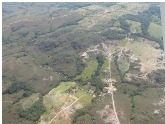
Foto 38: Região com alta suscetibilidade a erosão, interceptada pelas Macrodiretrizes na passagem por Monte Carmelo, após a travessia do reservatório da UHE Emborcação.
