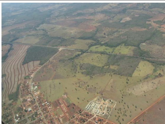
Foto 65: Vista do local de passagem da Macrodiretriz 6 pelas proximidades da sede de Estrela do Norte.
