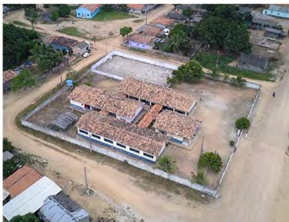
Figura 312 - Escola Santa Ana na Vila Novo Planalto.
