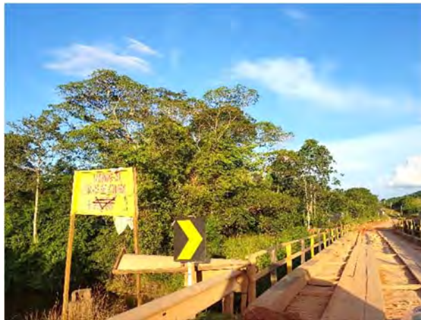
Figura 69 - Ponte de madeira na BR-230.
