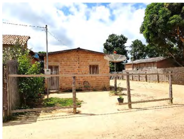
Figura 305 - Casa de alvenaria sem reboco.
