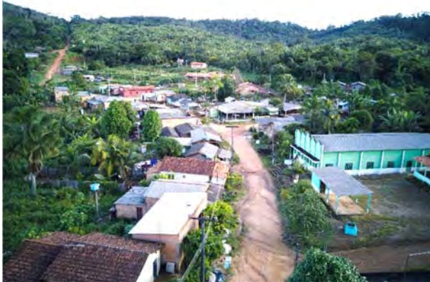
Figura 249 - Visão geral das moradias.
