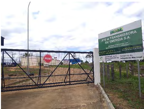
Figura 370 - Área da Subestação Itacaiunas.
