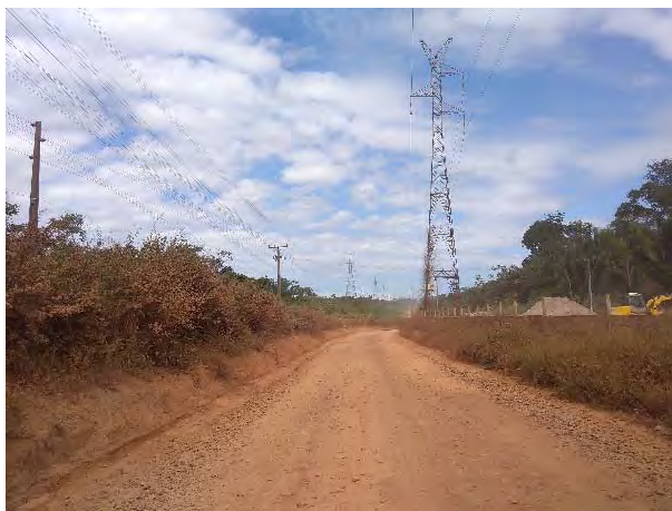
Figura 371 - Linhas de Transmissão na vicinal de acesso à Vila do Café.
