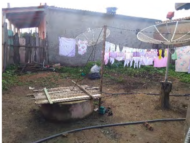
Figura 549 - Poço raso em residência da Vila Cruzeiro do Sul.
