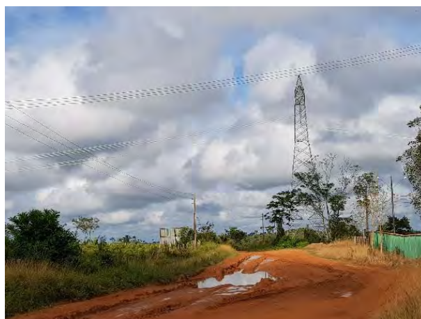
Figura 546 - Uso do solo e torre de linha de transmissão.
