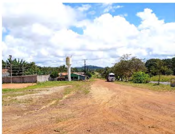
Figura 213 - Via interna sem pavimentação.
