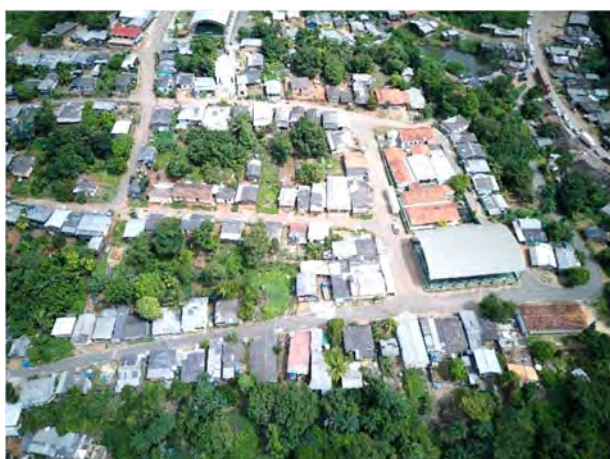
Figura 132 - Vias internas pavimentadas.
