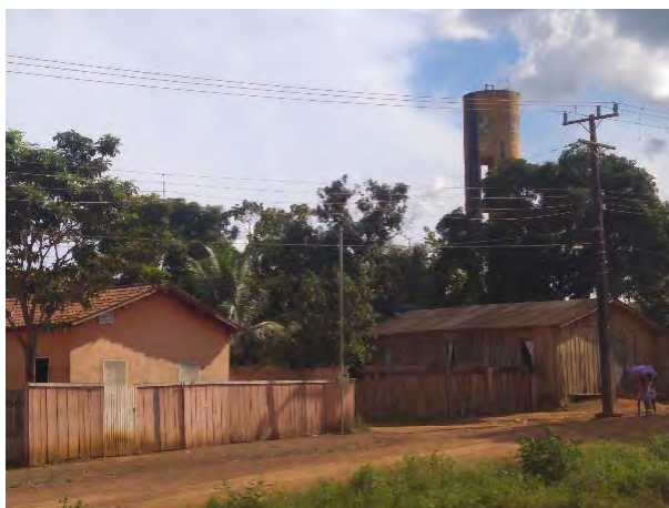
Figura 507 - Padrão construtivo e caixa d'água de poço artesiano comunitário.
