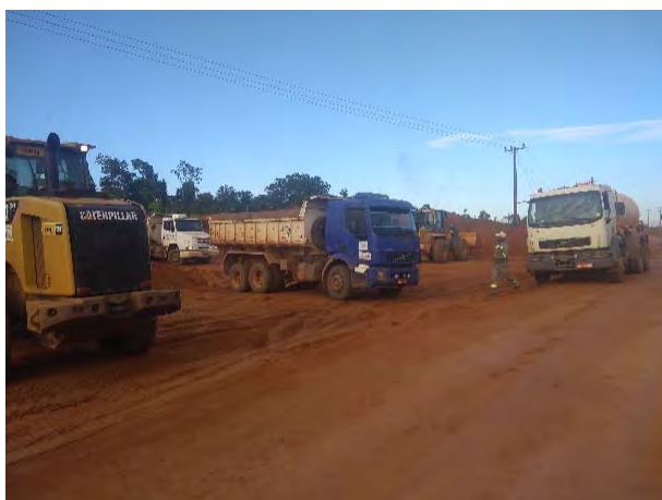
Figura 501 - Manutenção na via de acesso à Vila União.
