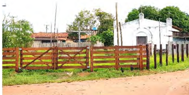
Figura 322 - Igreja Católica na Vila Neteolândia.
