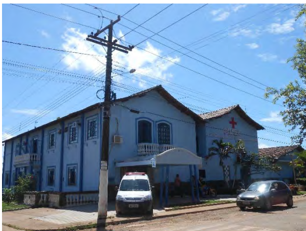
Figura 15 - Hospital Municipal de Eldorado do Carajás/PA
