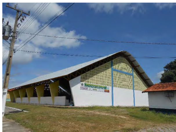
Figura 36 - Quadra Escolar Coberta da Escola Municipal Domingas Ribeiro em Pau D'Arco/TO.
