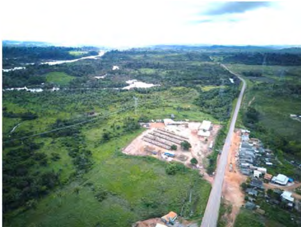
Figura 203 -Canteiro de obras da XRTE.
