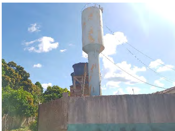
Figura 519 - Poço artesiano de atendimento à escola.
