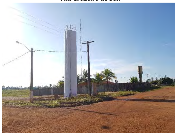
Figura 550 - Caixa d'água de poço artesiano que abastece a Vila Cruzeiro do Sul.
