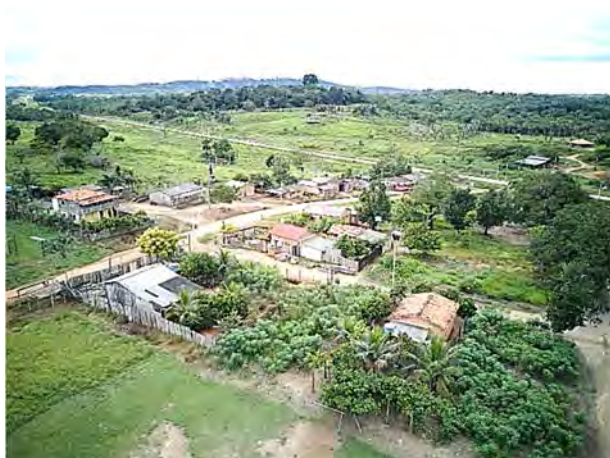
Figura 236 - Visão geral das moradias.
