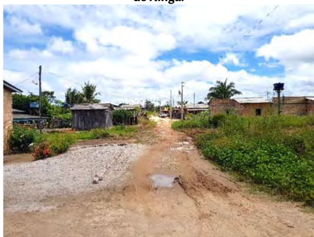
Figura 179 - Via sem pavimentação.
