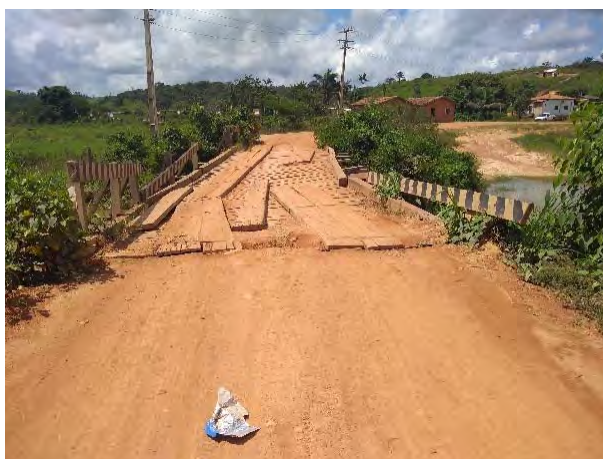
Figura 467 - Ponte de acesso à Vila Carimã.
