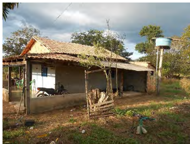
Figura 599 - Caixa d'água em residência no PA Paraíso do Araguaia.
