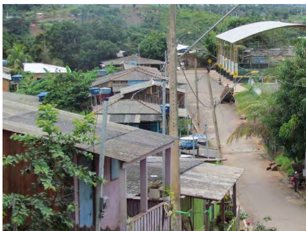
Figura 136 - Residências e iluminação pública na vila.
