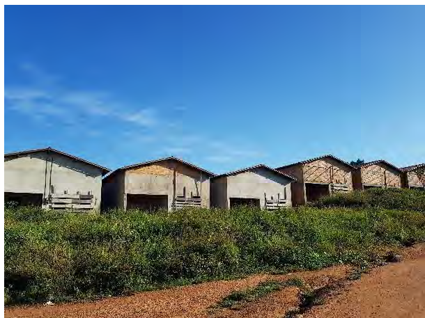
Figura 547 - Estrutura de moradia na Vila Cruzeiro do Sul.
