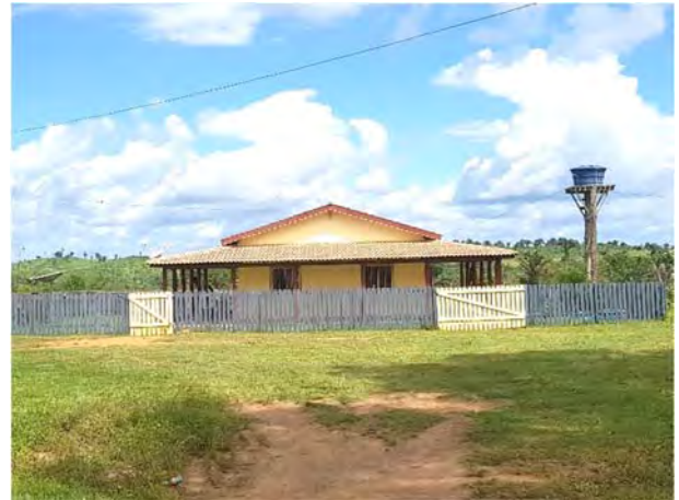
Figura 285 - Casa de alvenaria na Vila Novo Horizonte.
