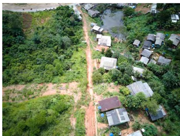
Figura 133 - Via sem pavimentação.
