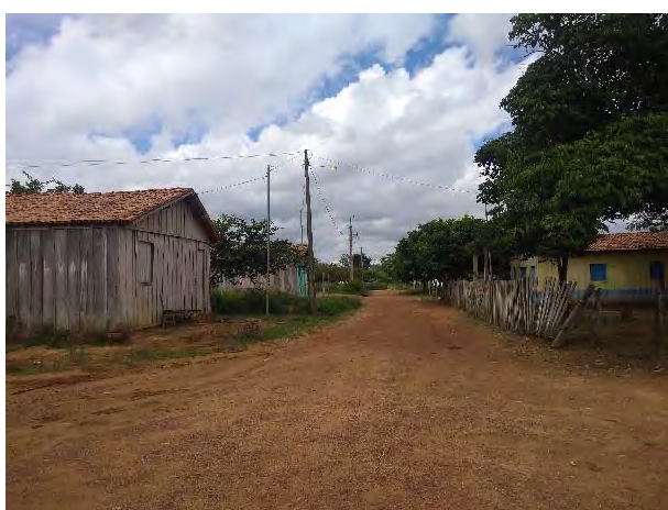
Figura 460 - Vila do PA Jardim com seu padrão construtivo e iluminação pública.
