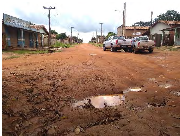
Figura 532 - Acesso à Vila São Pedro.
