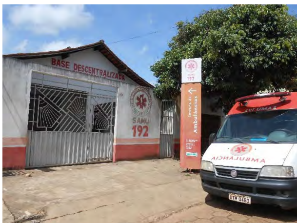
Figura 17 - Base Descentralizada do SAMU em Curionópolis/PA.
