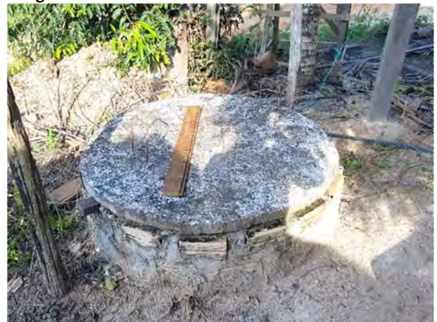
Figura 287 - Poço raso em residência na Vila Novo Horizonte.
