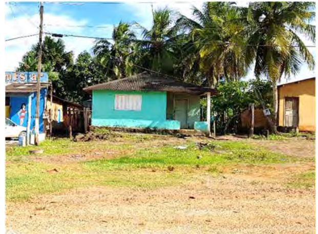
Figura 250 = Casa de alvenaria
