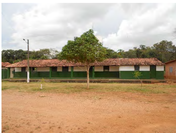
Figura 581 - Escola Municipal Núcleo São Miguel em Canto da Vazante.
