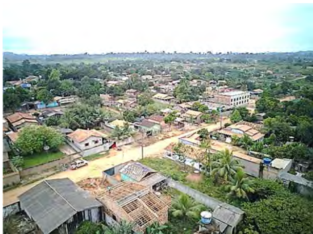
Figura 339 - Visão geral das moradias.
