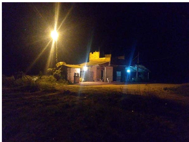
Figura 468 - Poste de iluminação pública na Vila Carimã.
