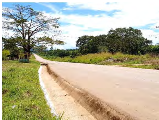
Figura 212 - Drenagem pluvial da BR-230 na Vila Sucupira.
