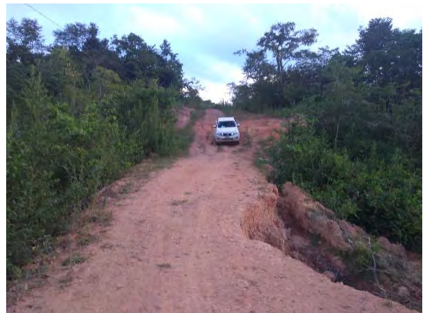
Figura 453 - Vicinal de acesso ao PA Taboqueiras.
