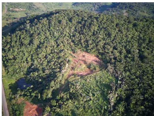
Figura 271 - Extração de material para construção civil dentro da vila.
