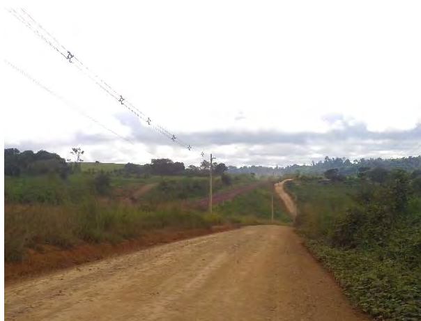
Figura 434 - Via de acesso ao PA 3 voltas.
