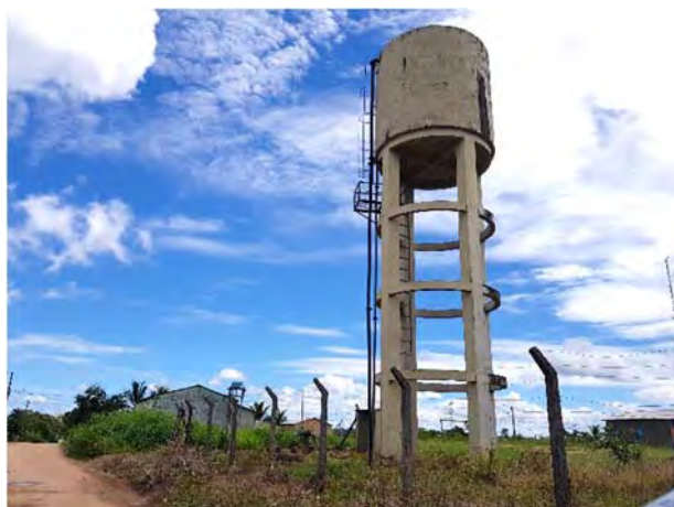
Figura 198 Caixa d'água de abastecimento da vila.
