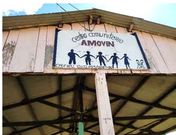
Figura 119 - Sede da associação de moradores da Vila Nazaré.
