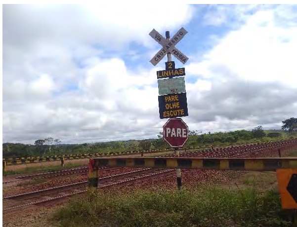
Figura 436 - Entrada para ramal de acesso ao PA 3 Voltas, cortado por ferrovia.
