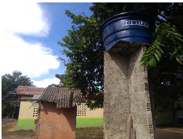
Figura 406 - Poço artesiano na Escola Municipal Castelo Branco.
