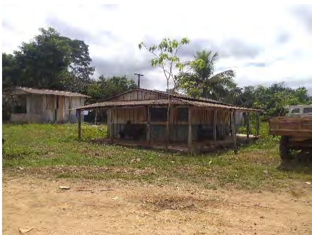
Figura 403 - Moradias em madeira na Vila Rica, PA Sereno.
