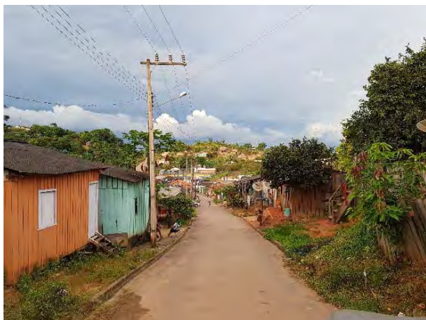
Figura 157 - Vias internas pavimentadas com iluminação pública.
