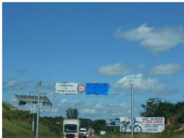
Figura 44 - PA-275 em Curionópolis/PA.
