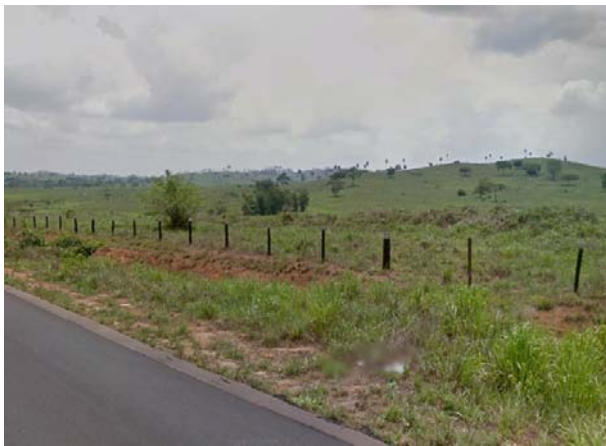
Figura 64. Áreas mais rebaixadas nas margens da rodovia PA-275. Ao fundo, relevo acidentado da Serra dos Carajás. Coordenadas UTM 641753 E / 9326376 N FUSO 22S.
