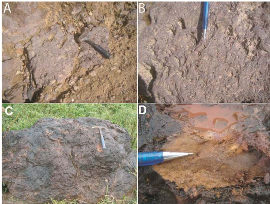
Figura 89. Diferentes aspectos dos depósitos de crosta laterítica. A e B) crosta laterítica muito dura com sulcos irregulares e descontínuos. C e D) Crosta laterítica alterada de coloração vermelha. Coordenadas UTM/WGS84 - 22S. A e B) 444613E/9647422N e C e D) 686770E/9198668N.
