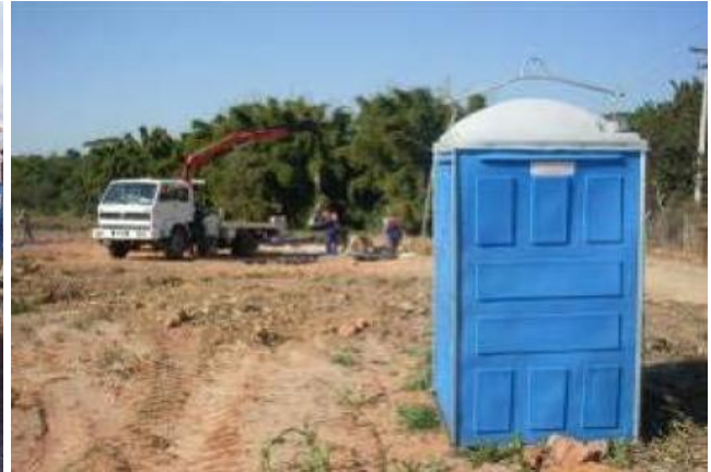
Foto 11 – Banheiro químico localizado na praça de serviço, no canteiro de obras.
