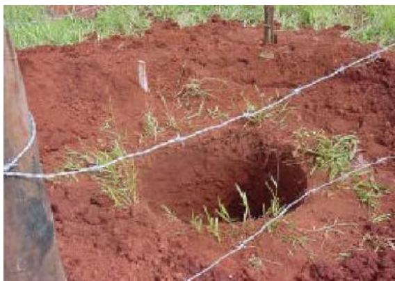
Foto 30 – Detalhe da escavação com broca no mastro central.
