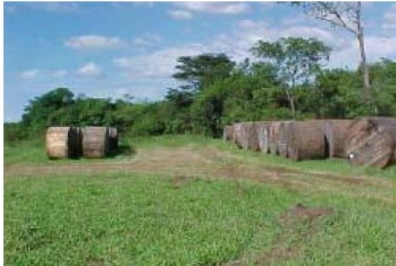
Foto 19 – Organização dos carretéis na praça de lançamento de cabos.
