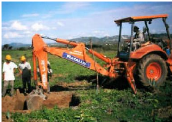
Foto 28 – Escavação de fundação de uma torre.
