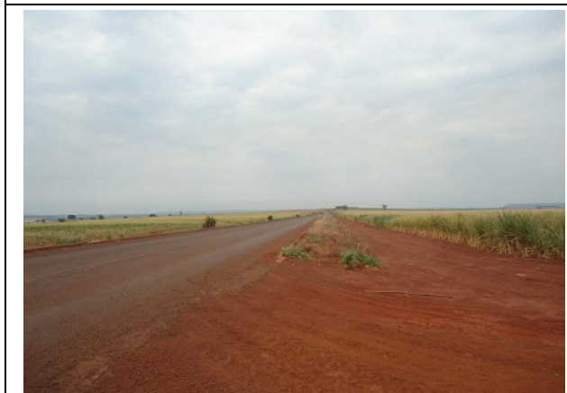
Foto 8.3.3-17 – Rodovia GO-501 Coord.: 544.263 E / 8.015.787 S
