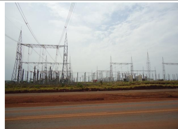
Foto 8.3.3-12 – Rodovia BR-060, em duplicação, com acesso para a SE Rio Verde Norte Coord.: 514.617 E / 8.040.196 S
