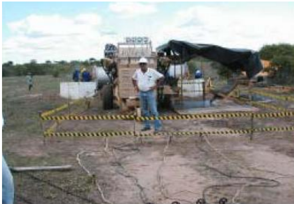
Fotos 17 e 18 – Praça de lançamento de cabos feita corretamente.
