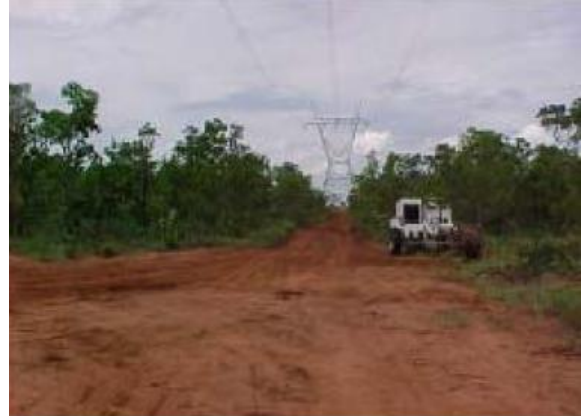
Foto 16 – Acesso utilizando faixa de serviço.
