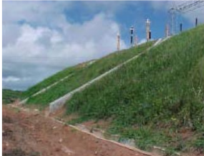
Foto 25 – Taludes com dispositivos de drenagem.
