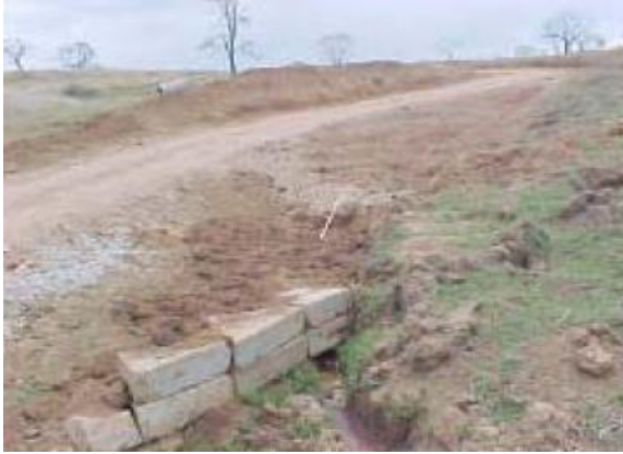
Foto 15 – Dispositivos de contenção de acessos.
