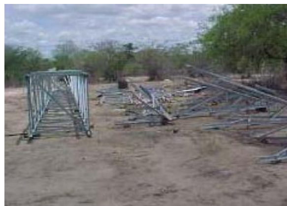
Fotos 32 e 33 – Processo de montagem das torres.
