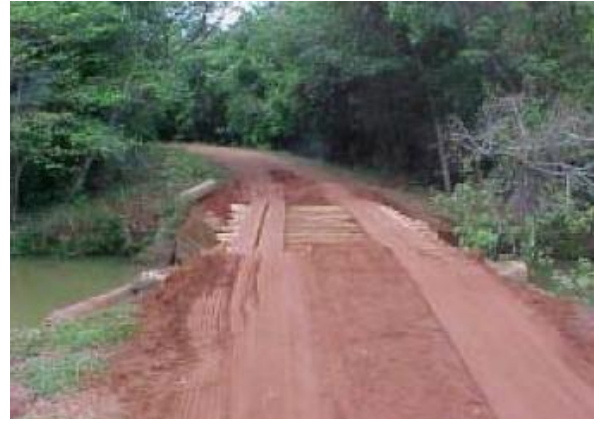
Foto 14 – Pontes provisórias para evitar danos aos cursos d'água.
