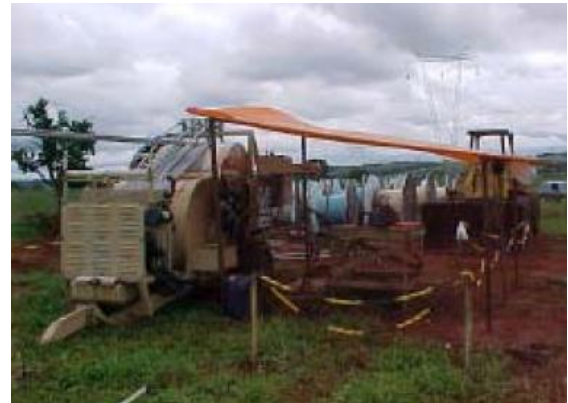
Fotos 17 e 18 – Praça de lançamento de cabos feita corretamente.
