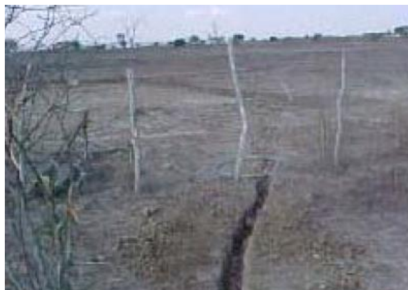
Foto 39 – Vala para instalação de aterramento.
