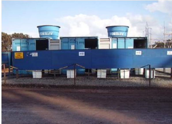
Foto 10 – Modelo de banheiro hidráulico a ser utilizado em locais sem infra-estrutura apropriada.
