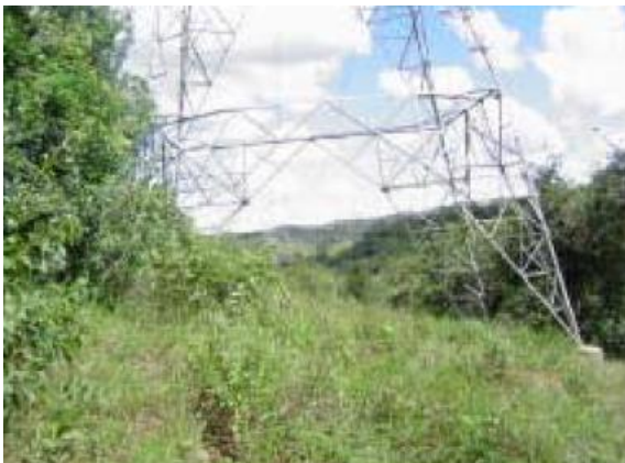
Foto 40 – Revegetação com capim nativo logo após o nivelamento final do terreno.
