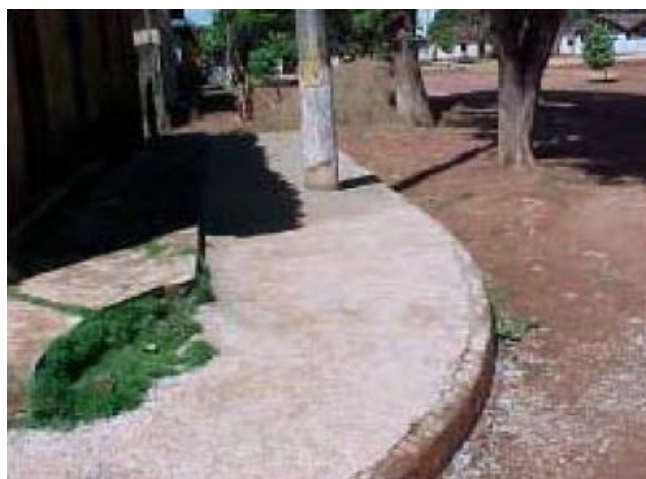
Foto 21 – Disposição apropriada de restos de concreto.
