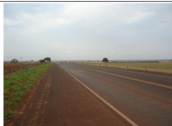
Foto 8.3.3-18 – Rodovia GO-164 Coord.: 552.594 E / 8.009.153 S
