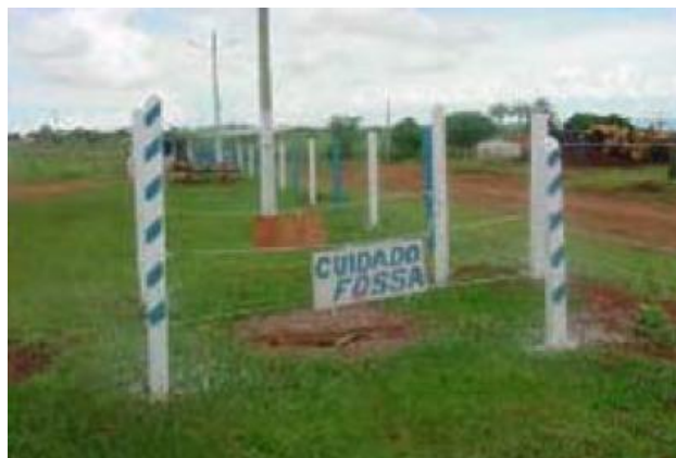
Foto 9 – Tratamento e disposição apropriada de esgoto gerado no canteiro.
