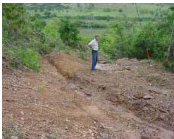
Foto 23 – Dispositivo provisório de drenagem para evitar erosão na área da torre.
