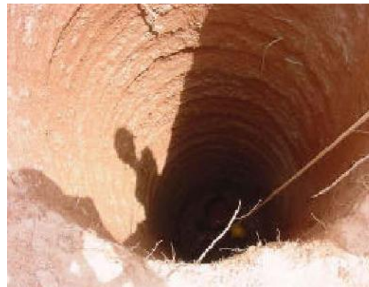
Foto 29 – Escavação de uma fundação.
