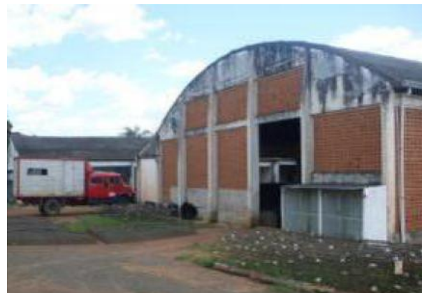
Foto 7 – Exemplo de canteiro em vista externa. Galpão em bom estado de manutenção. Armazenamento de bobinas.
