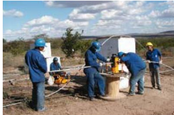
Foto 20 – Lançamento de cabos.
