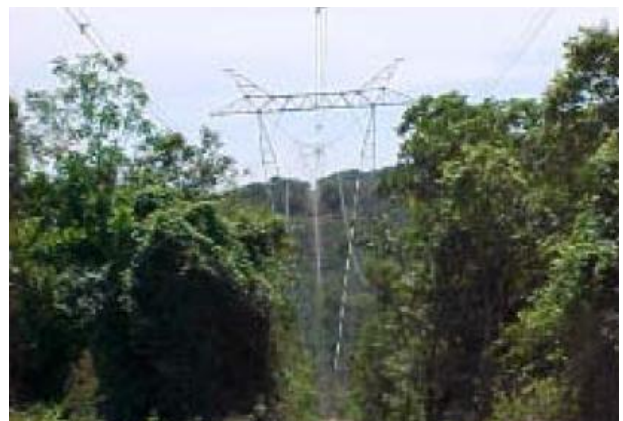
Foto 2 – Abertura da faixa com 3m de largura e corte seletivo da vegetação.
