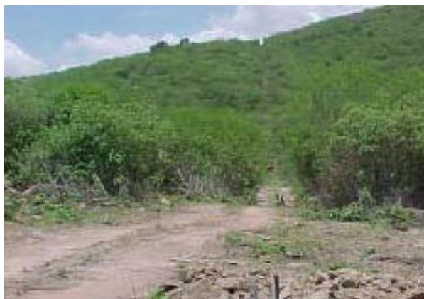
Foto 1 – Abertura de faixa com largura de 3m e o acesso no eixo da LT.
