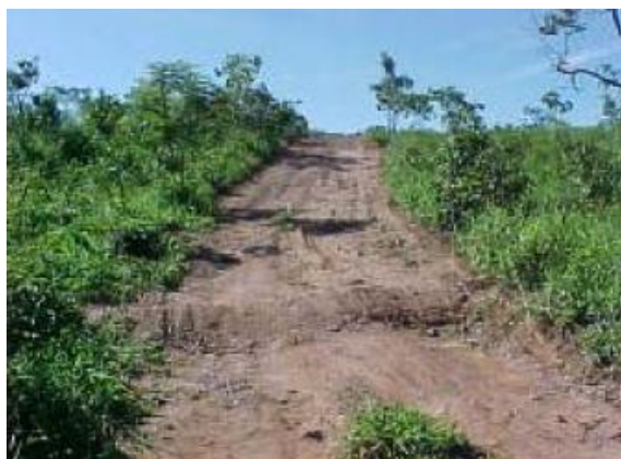
Foto 22 – Dispositivo de dissipação para evitar erosão nos acessos.
