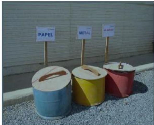
Foto 12 – Recipientes de coleta e armazenamento temporário de lixo no canteiro de obras.
