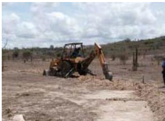
Foto 38 - Uso de trator para instalação de aterramento
