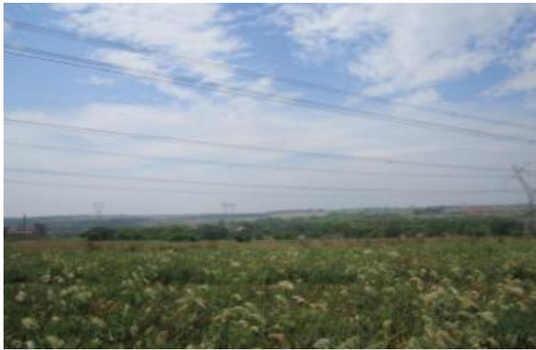
Foto 8.2.2-148 – Estação Amostral F35 - Área da Subestação Fronteiras
