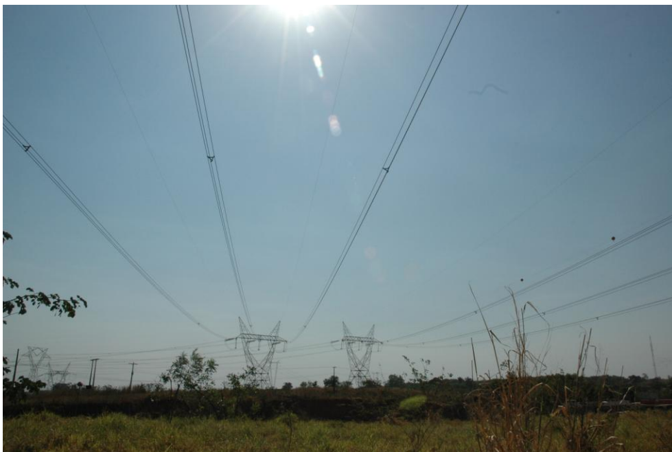
Foto 10 – Local previsto para um dos seccionamentos com as LTs 500kV Marimbondo – Araraquara C1 e C2 (LTs de FURNAS)
