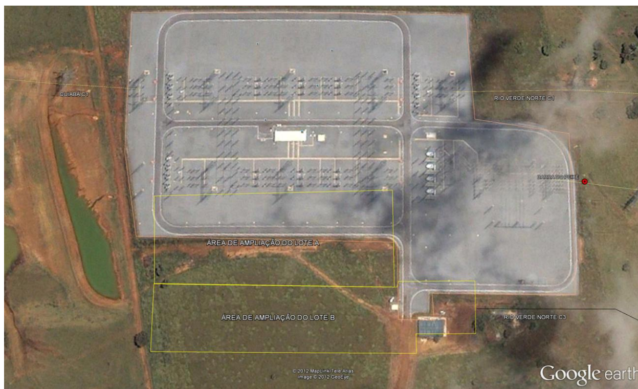
Foto 1 – Vista aérea da SE 230/500kV Ribeirãozinho.
