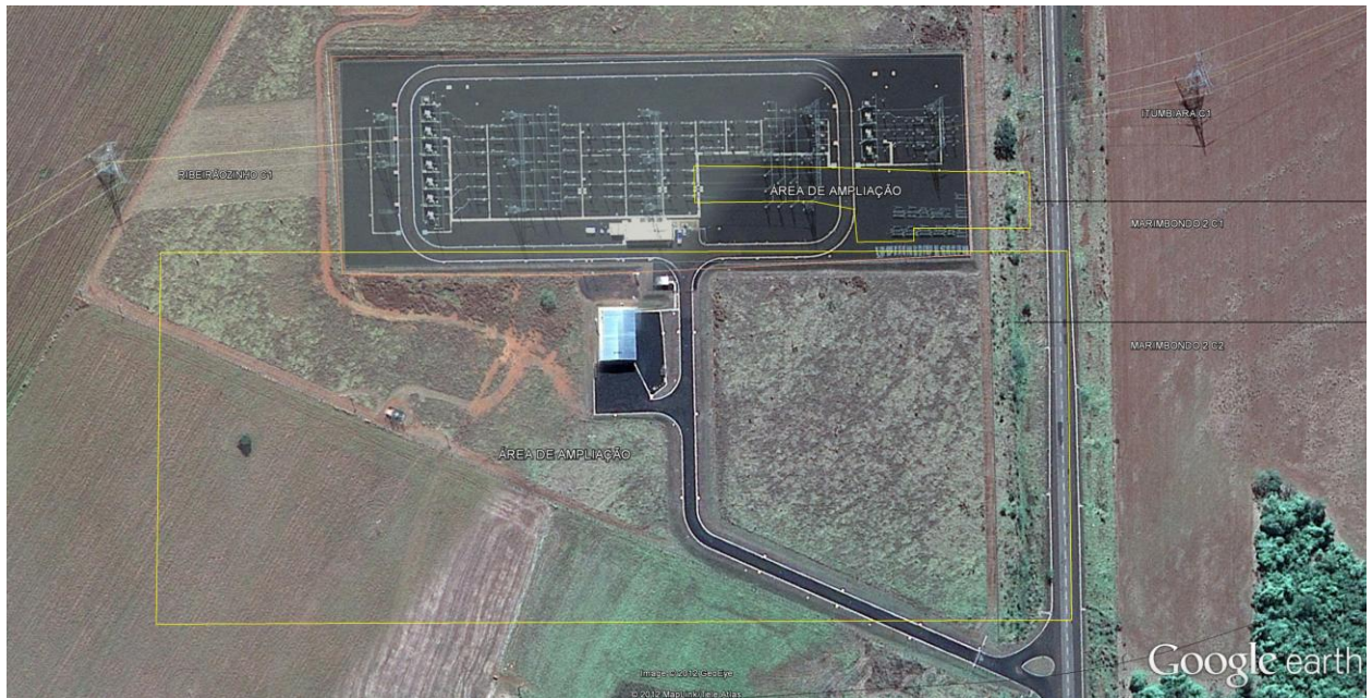
Foto 3 – Vista aérea da SE 500kV Rio Verde Norte.
