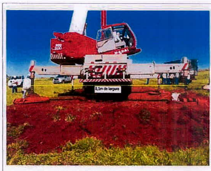
Foto 2 – Outros detalhes do guindaste utilizado na montagem (largura) das torres
