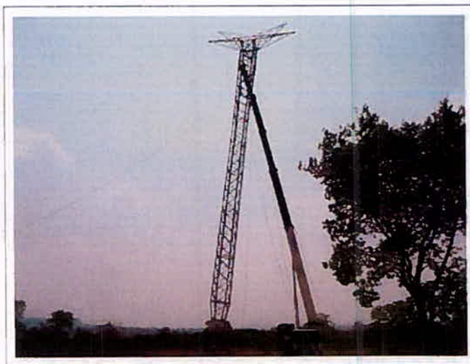
Foto 4 – Exemplo da utilização do guindaste no içamento da torre estaiada.
