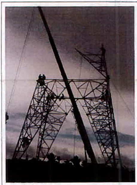
Foto 3 – Exemplo da utilização do guindaste na montagem da torre autoportante.
