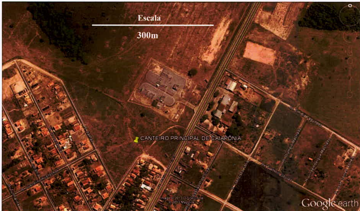
Figuras 4, 5 e 6 – Localização do Canteiro de obras de Caiapônia (GO). Fonte: Programa Google Earth (2013).
