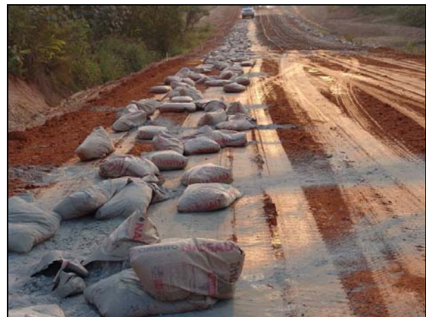
Figura 3.6.3.2.1.1-14: Na construção da BR 364 entre Tarauacá e Cruzeiro do Sul, pela ausência de brita (“pedra”), é utilizada uma camada de cimento para dar suporte ao leito da estrada. Fonte: Lani (2008).
