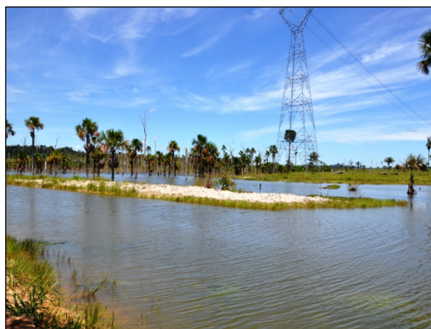
Figura 3.6.3.9.3-10: Área de alagamento por ação antrópica, açude. A área de alagamento próximo à torre de transmissão pode ocasionar mudanças estruturais nos solos e afetar a estrutura de base da torre. (Fonte: Gomes, 2010).
