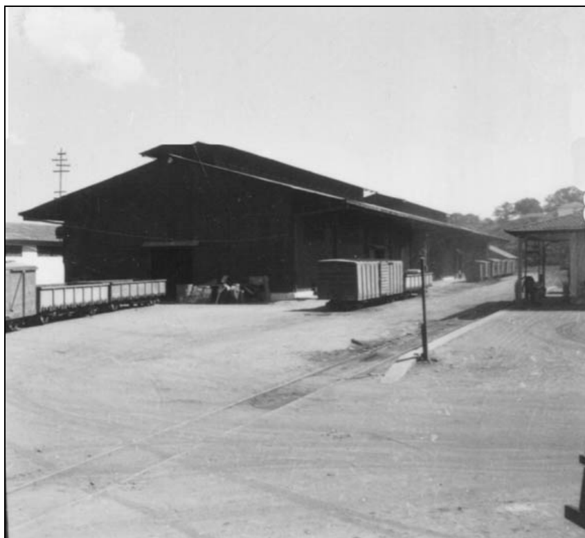
Figura 3.6.5.2.1.5-6: Estação da EFMM em Porto Velho (RO), 1968. Fonte: http://biblioteca.ibge.gov.br/
