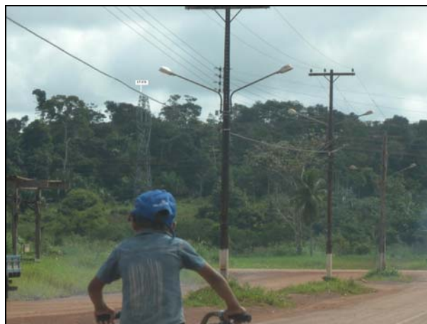
Figura 3.6.8.3-4: Linha de Transmissão (C1) avistada da área urbana do distrito de Nova Califórnia – Porto Velho, 2010.
