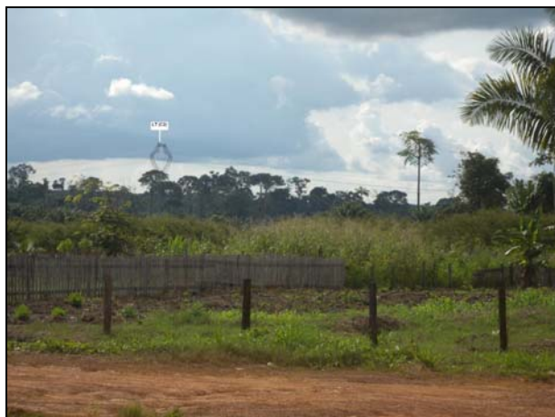
Figura 3.6.8.3-3: Linha de Transmissão (C1) avistada da frente da Escola José Augusto da Silva na área urbana do distrito de Extrema – Porto Velho, 2010.
