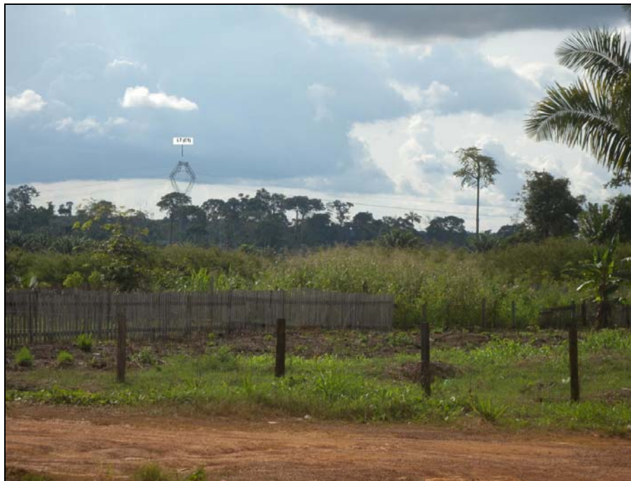
Figura 3.6.5.4.2-1: Vista da LT Porto Velho – Rio Branco (C1) da porta da EMEF José Augusto da Silva no distrito de Extrema, Porto Velho, RO, 2010. Fonte: José Ambrósio Ferreira Neto, abril, 2010.
