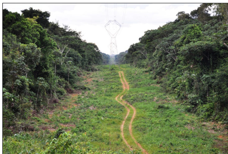
Figura 3.6.3.9.3-20: Estrada de acesso sem a aplicação de técnicas de conservação e retenção de enxurradas às margens da estrada. A aplicação das técnicas visa reter o escoamento superficial proporcionando redução do processo erosivo e manutenção da estrada. (Fonte: Lani, 2010).
