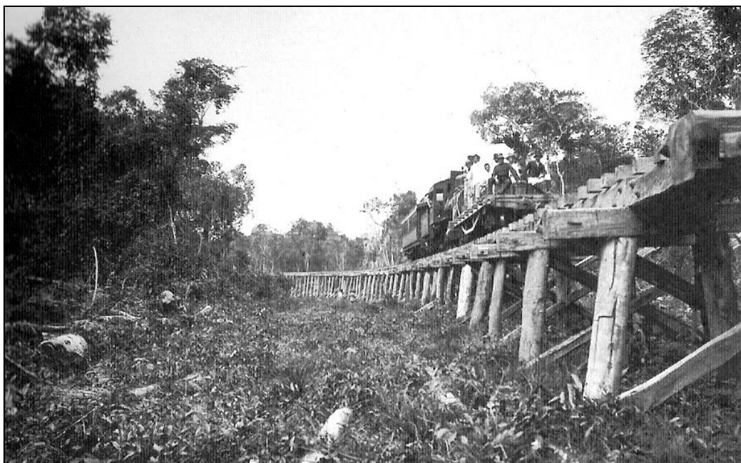
Figura 3.6.5.2.1-7: Trecho suspenso da Estrada de Ferro Madeira Mamoré, 1910 Fonte: Hardman, 2005 – Foto de Dana Merrill.
