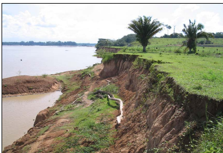
Figura 3.6.3.5.2-9: Falésias fluviais da margem esquerda do rio Madeira a jusante da corredeira Morrinhos. A erosão fluvial, nesse trecho, manifesta-se em grande extensão, através do progressivo solapamento da base das margens em talude (barrancas), gerando o fenômeno de “terras caídas” Rondônia. Fonte: NEPUT/UFV, 2010.
