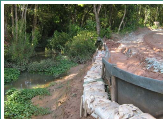
Foto 45: Exemplo de medida do PAC: contenção - controle de erosão e assoreamento.
