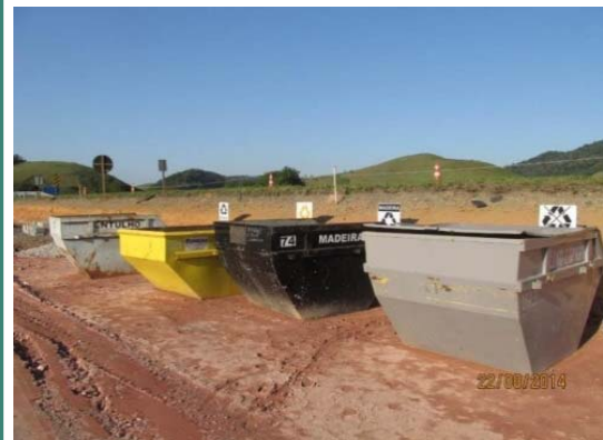
Foto 43: Exemplo de medida do PAC: gestão de resíduos sólidos - construção civil.
