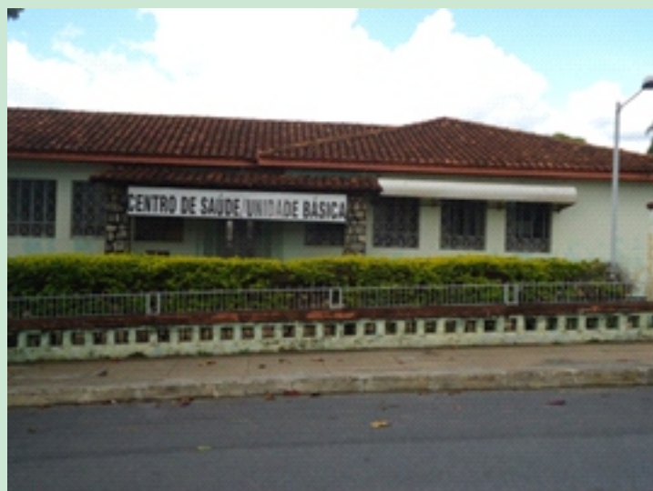
Foto 34: Hospital Municipal Jenny Negrão de Lima, Povoado de São José das Lajes, município de Cordisburgo - MG.
