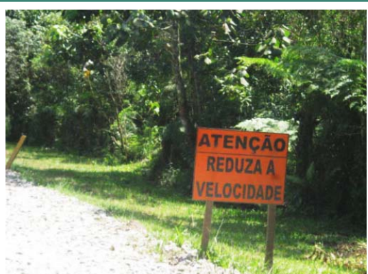
Foto 46: Exemplo de medida do PAC: controle de sinalização de obra.
