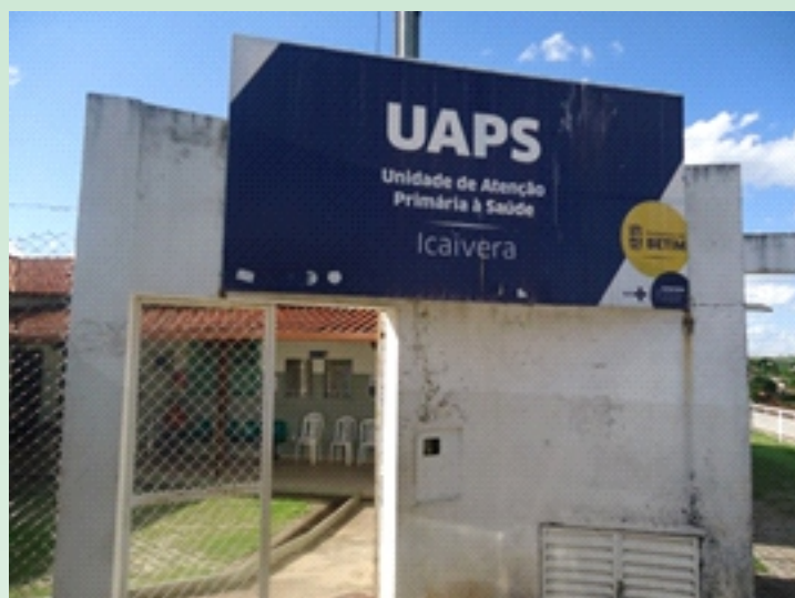
Foto 36: Unidade de Atendimento Prioritário em Saúde (UAPS) Icaivera, Bairro Icaivera, município de Betim - MG.
