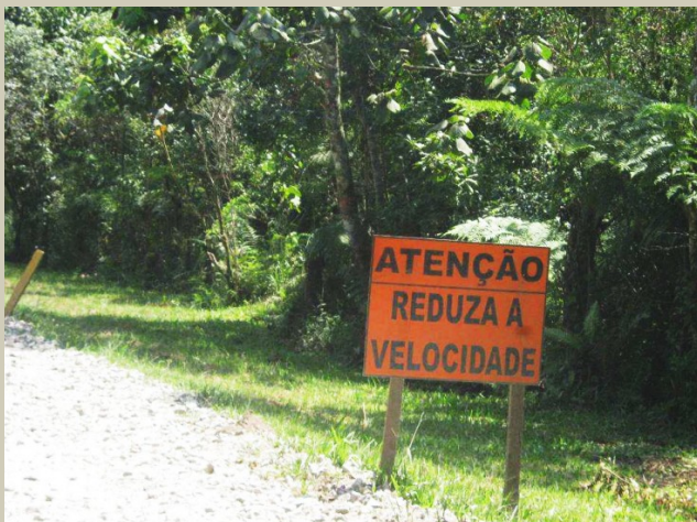
PAC: controle de sinalização de obra.
