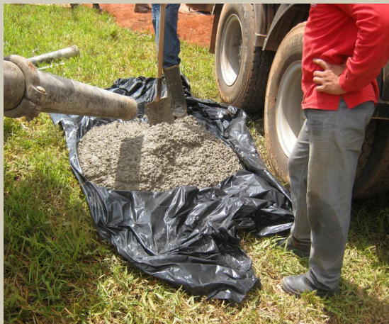
PAC: gestão de resíduos - restos de concreto.
