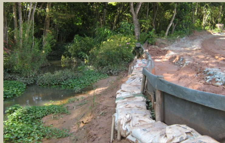
PAC: contenção - controle de erosão e assoreamento.
