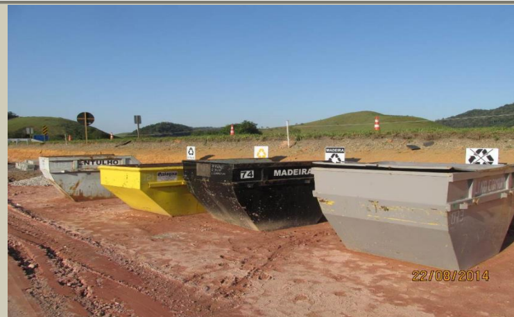
PAC: gestão de resíduos sólidos - construção civil.
