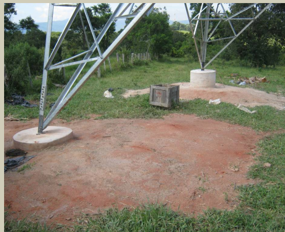
PAC: limpeza das bases das torres.
